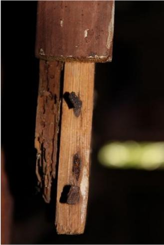
Figura 41. Clavos oxidados que han causado el faltante en el marco.
