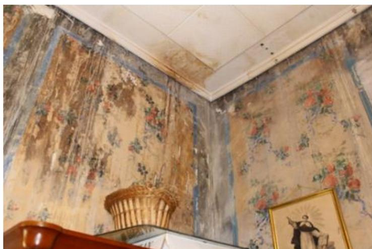
Figura 49. Humedades por infiltración desde la cubierta.
