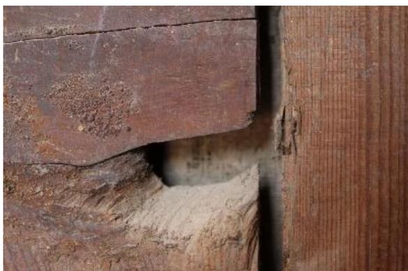
Figura 38. Desprendimiento de un nudo.
