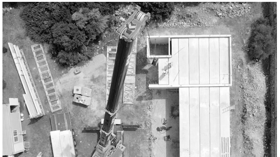
Fig. 15. Montaje estructura. Ubiko
