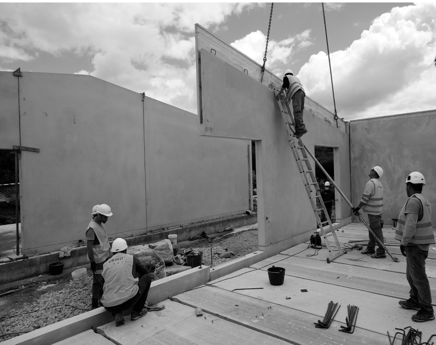
Fig. 17. Montaje estructura. Ubiko
