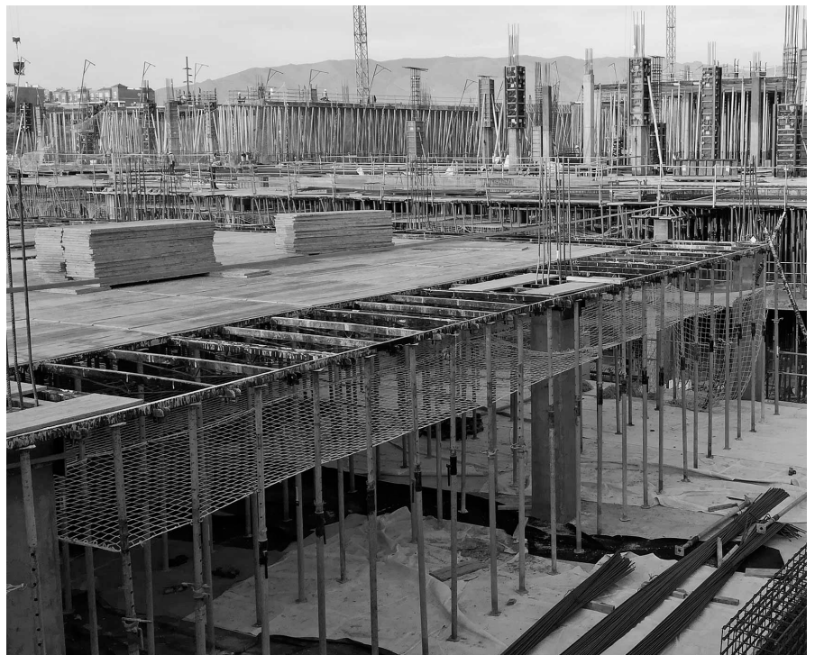
Fig. 9. Encofrado in situ. Ulmaconstruction.
