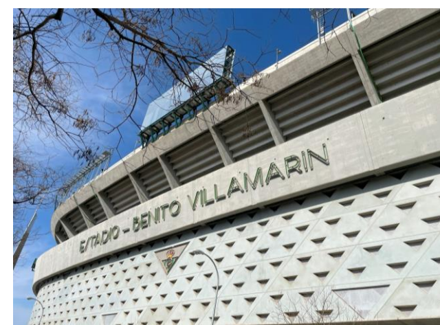
Fig. 93. Estado actual fachada Gol Sur.
