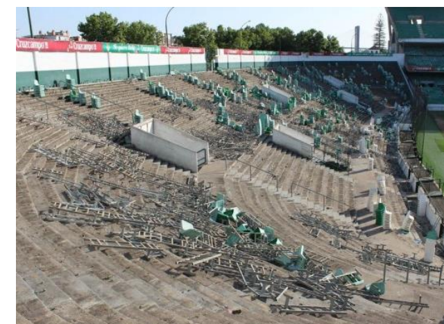
Fig. 89. Trabajos previos a la demolición del Gol Sur.
