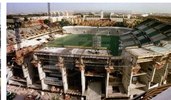
Fig. 82. Construcción Gol Norte y Tribuna de Fondo. Verano de 1998.
