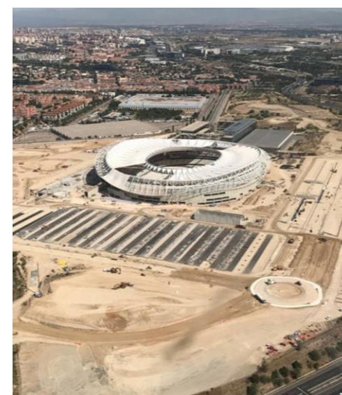
Fig. 71. Emplazamiento en construcción del Wanda Metropolitano en la periferia urbana de Madrid.
