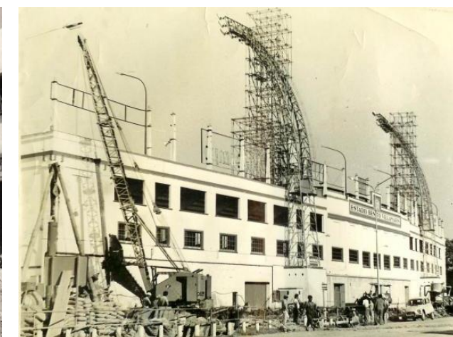
Fig. 73. Retiro de las torres de iluminación innecesarias tras la construcción del Voladizo.
