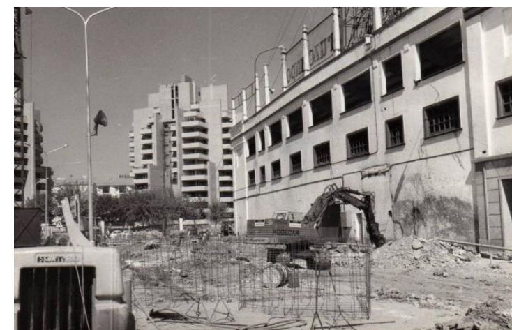
Fig. 72. Inicio de las obras de cimentación de la grada del Voladizo.
