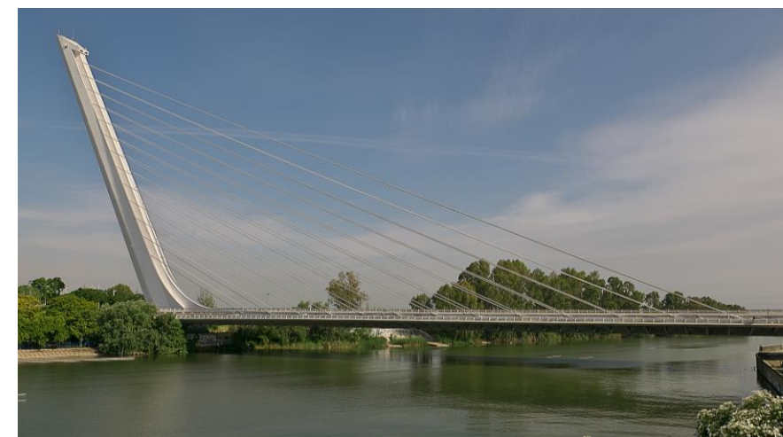
Fig. 47. Puente del Alamillo. Acceso a la Isla de la Cartuja.
