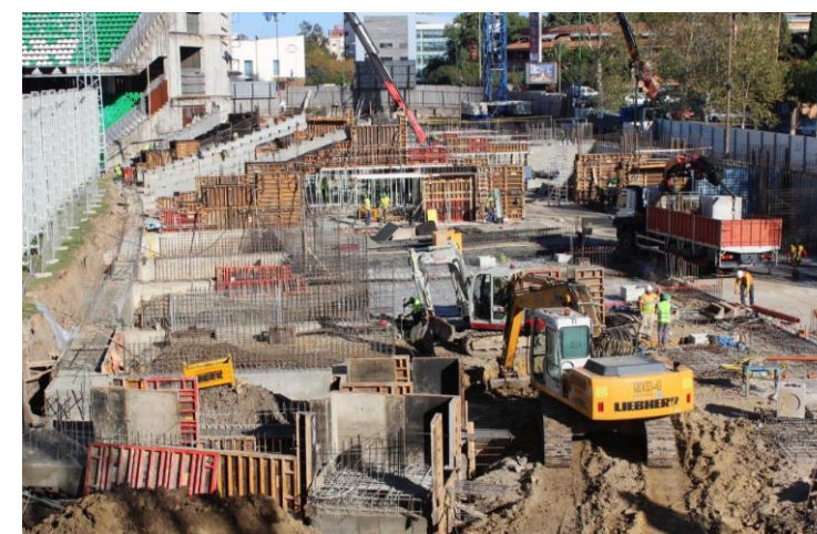
Fig. 90. Ejecución del encofrado y posterior vertido del hormigón en el primer nivel del porticado.
