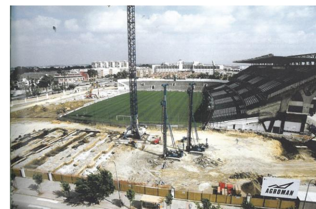
Fig. 81. Inicio de las obras de cimentación tras el derribo del Gol Norte y la Tribuna de Fondo. Verano de 1998.
