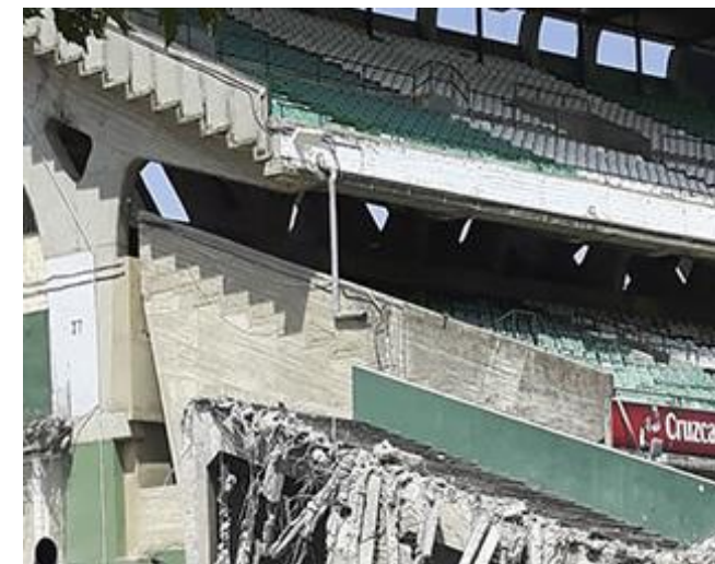
Fig. 149. Encuentro entre ambas gradas.
