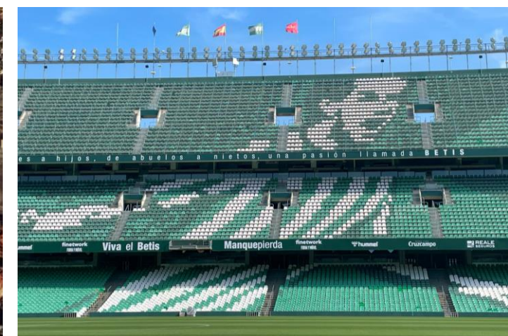
Fig. 84. Estado actual de la Tribuna de Fondo.
