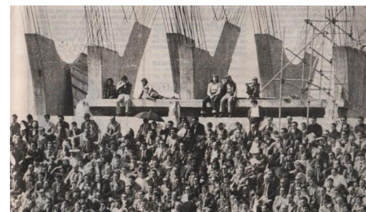
Fig. 74. Obras del Voladizo durante el encuentro entre el Real Betis Balompíe y el Racing. Jornada 30 del Campeonato de Liga de Primera División. 11 de abril de 1976.
