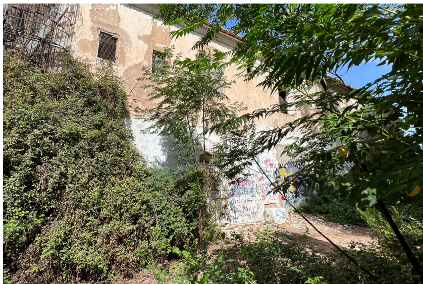
Imagen 6. Vista exterior de la Alquería de la Torre desde el este, Septiembre 2023 - fuente propia
