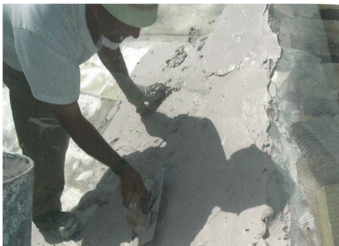
Imagen 67. Detalle de la aplicación del rehenchido de yeso con una llana, F. Vegas y C. Mileto (24)
