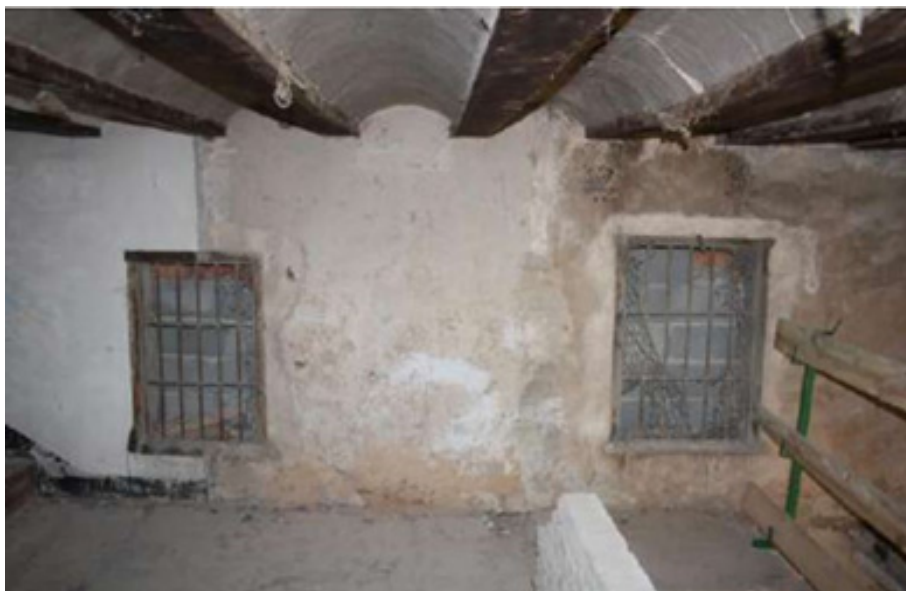
Imagen 32. Vista de como se apoya el forjado al muro de carga (12)
