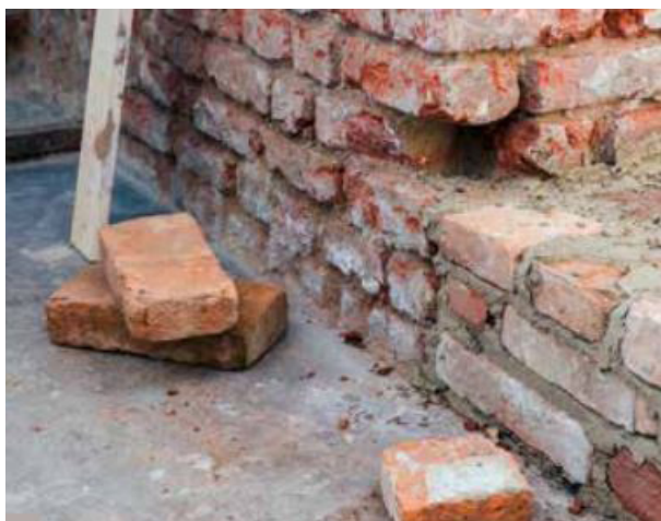
Imagen 61. Eliminación de elementos dañados, MAPEI (23)
