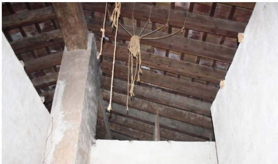
Imagen 49. Detalle de la cubierta a dos agua y de su viga cumbre (12)
