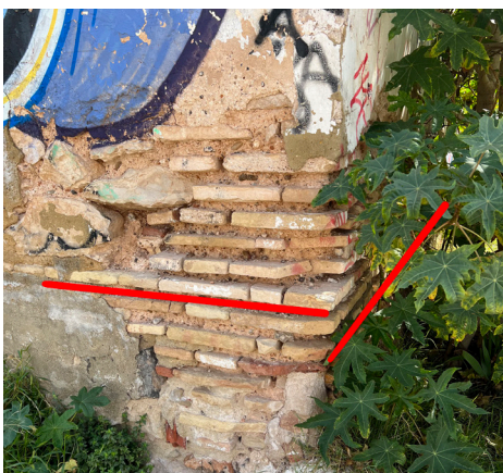
Imagen 59. Esquema de inserción de las barras en el edificio - elaboración propia
