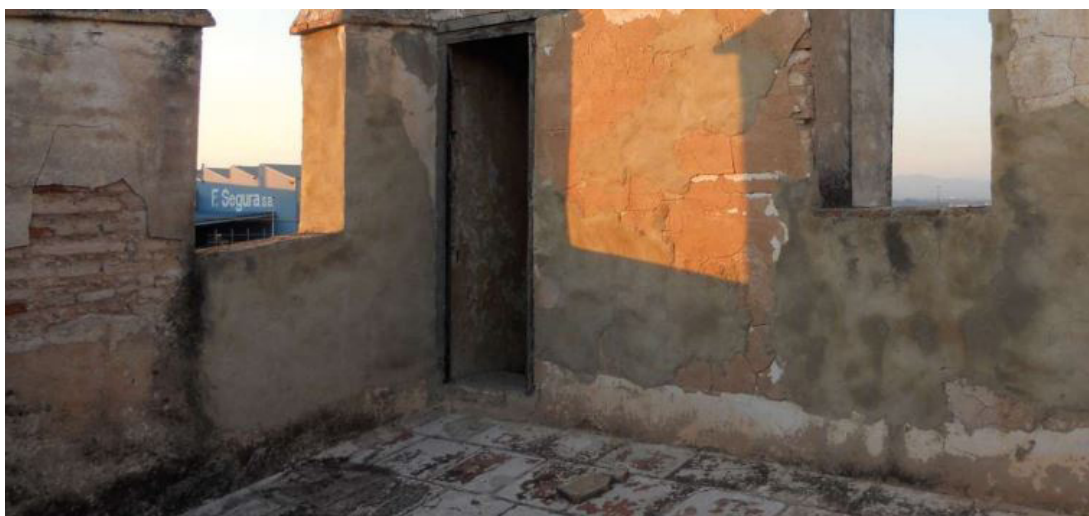
Imagen 22. Vista exterior de la cubierta plana de la torre de la Alquería donde se puede apreciar el parapeto (11)
