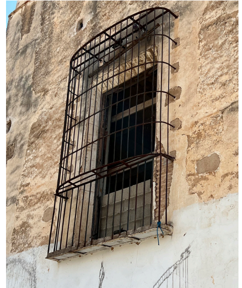
Imagen 24. Vista exterior de la ventana, Septiembre 2023 - fuente propia
