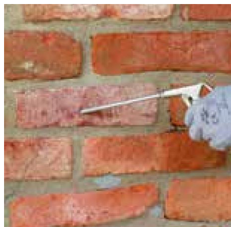
Imagen 55. Eliminación material no cohesionado con aire comprimido, MAPEI (21)
