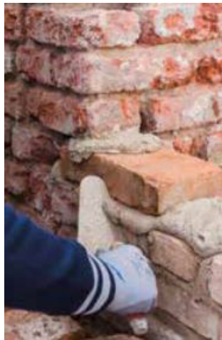
Imagen 62. Cosido del muro, MAPEI (23)
