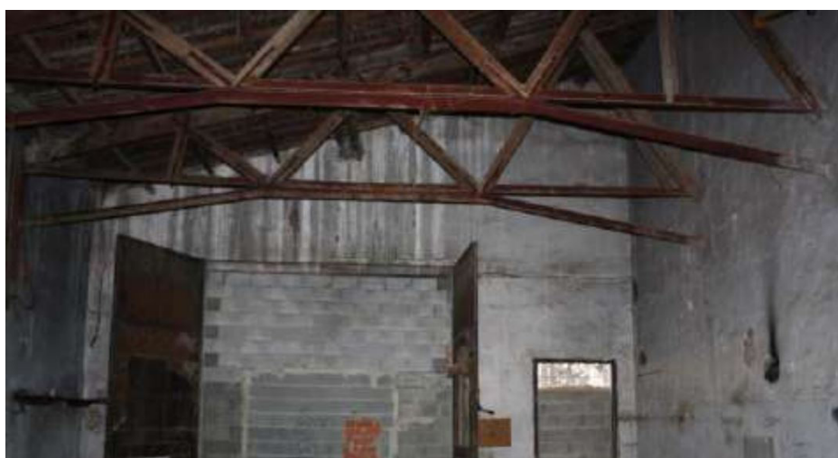
Imagen 51. Detalle de la cubierta a una agua del volumen anexo (12)
