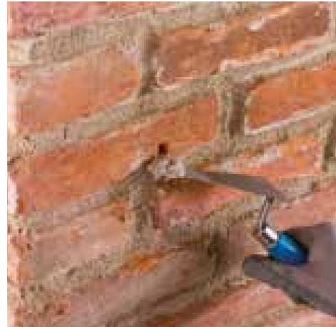
Imagen 57. Relleno agujero con mortero, MAPEI (21)
