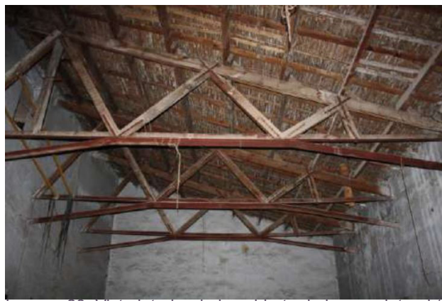
Imagen 23. Vista interior de la cubierta de la nave lateral (12)
