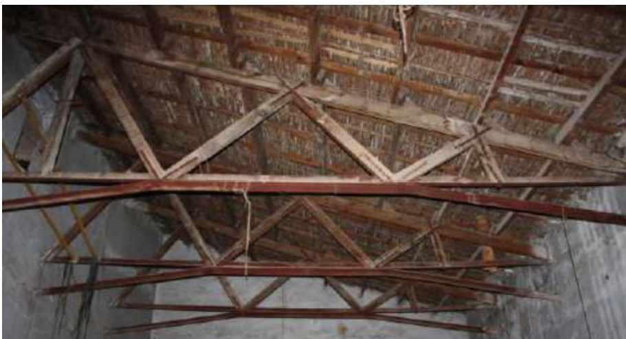
Imagen 23. Vista interior de la cubierta de la nave lateral (12)
