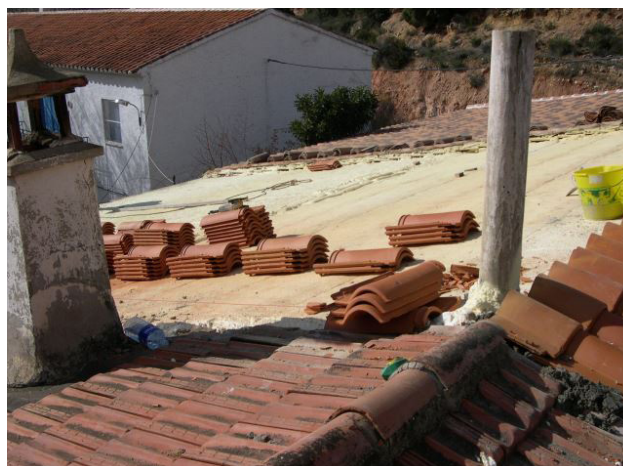
Imagen 66. Detalle proyección de la espuma de poliuretano, IPUR (26)
