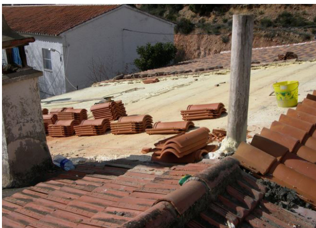
Imagen 65. Detalle proyección de la espuma de poliuretano, IPUR (26)
