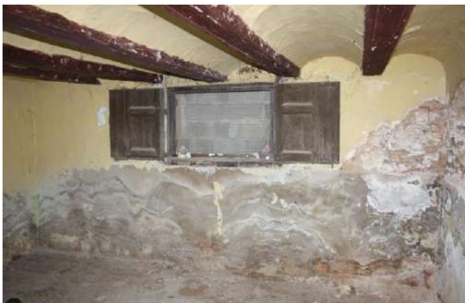
Imagen 43. Vista interior del forjado de la estructura horizontal (12)
