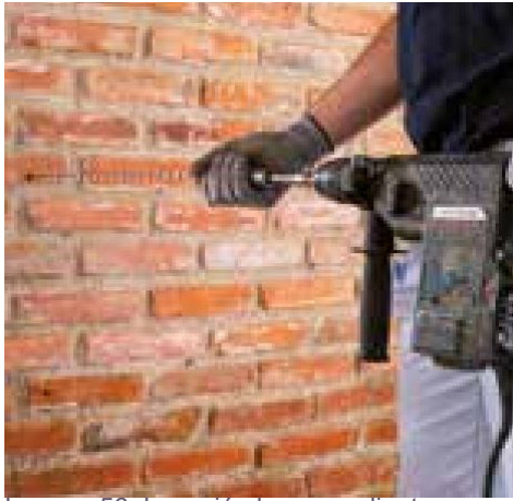
Imagen 56. Inserción barra mediante percusión, MAPEI (21)
