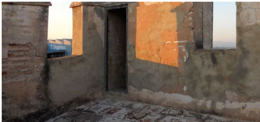
Imagen 22. Vista exterior de la cubierta plana de la torre de la Alquería (11)
