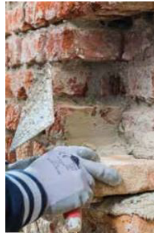
Imagen 63. Colocación de los elementos constructivos MAPEI (23)
