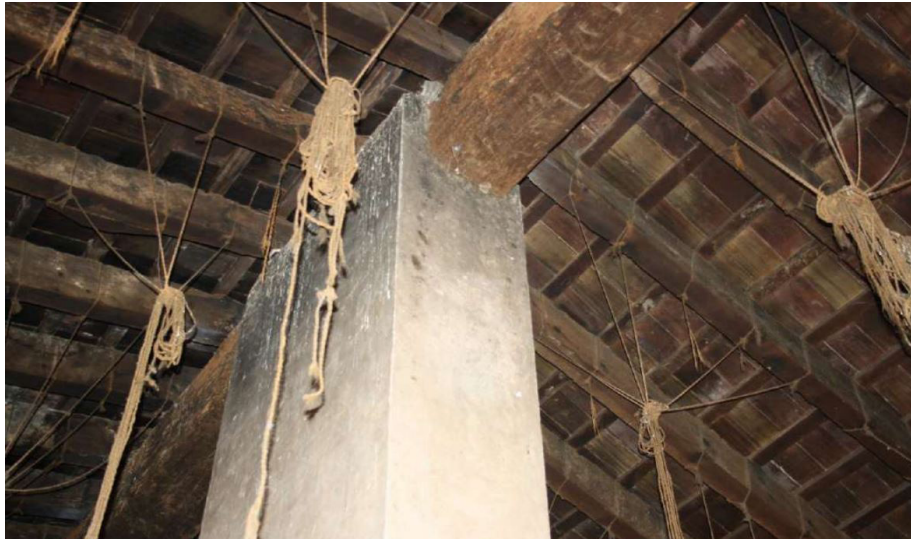
Imagen 21. Vista interior la cubierta a dos aguas y de la viga cumbreira (12)
