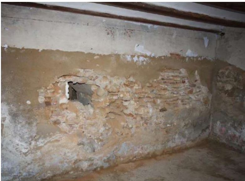
Imagen 16. Vista de los muros de la estructura resistente desde el interior, (12)
