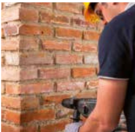
Imagen 54. Realización de perforaciones, MAPEI (21)
