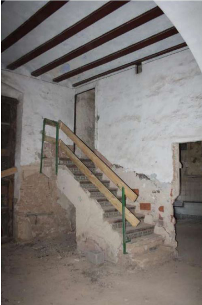
Imagen 27. Vista interior de la escalera de tramo recto (12)
