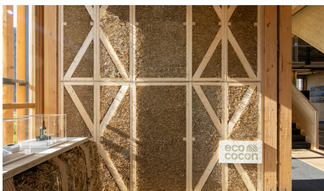
Figura 24. Muro con aislamiento de paja. DP6 (2020).
