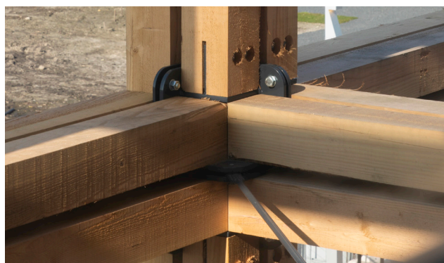
Figura 25. Uniones de vigas y pilares. DP6 (2020).
