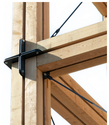
Figura 29. Vigas y pilares de madera aserrada de pino. DP6 (2020).
