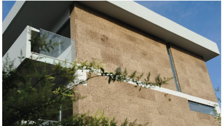
Figura 33. Fachada con revestimiento exterior de planchas de corcho. Sofalca (2017).
