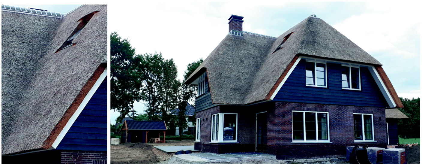
Figura 19. Uso de paja como cubierta. Sandak, Anna et al. (2019).
