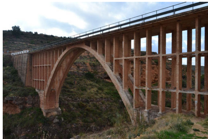
Fig. 2 Puente de Hinojares sobre el río Zumeta (Jaén). Tablero superior apoyado mediante entramados en dos arcos gemelos de 32 m de luz. Proyecto de José Olivares (1931)
