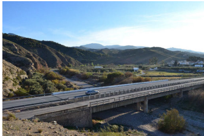
Fig. 4 Puente sobre el río Almanzora en la carretera A-334 junto a Armuña (Almería). El tráfico discurre por el nuevo puente, construido inmediatamente al lado del antiguo de hormigón armado
