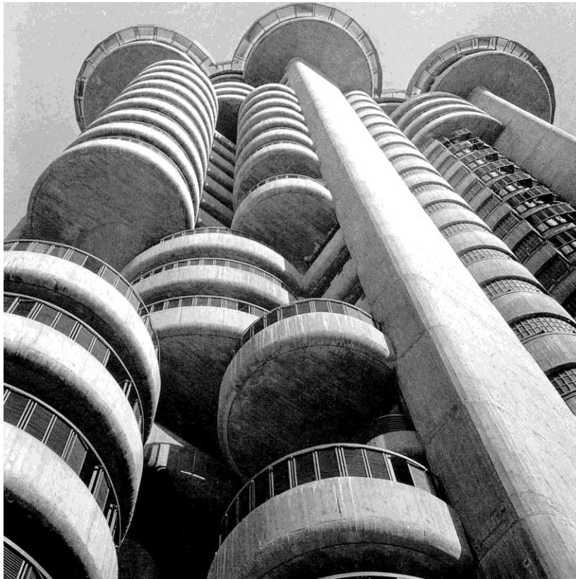
Imagen 41. Torres Blancas, Sáenz de Oiza, 1969 Madrid. Fotografía no conocido
