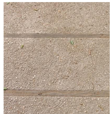
Imagen 4.1.10. Pavimento duro: losa de hormigón in situ.
