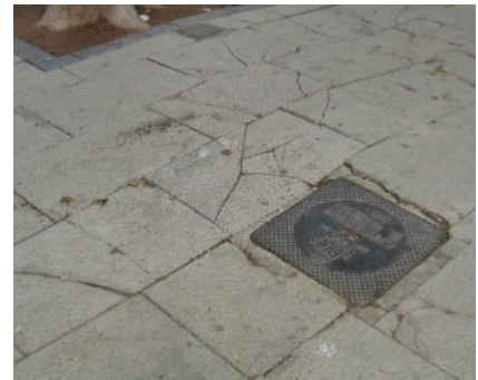
Imagen 4.2.10. Pavimento duro: baldosa de hormigón.
