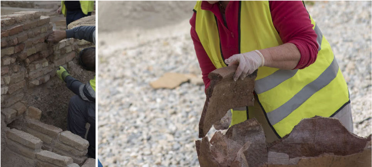
Fig. 6 Trabajos de consolidación de estructuras y piezas arqueológicas. Fuente: Gómez Carrasco, J. (2019).
