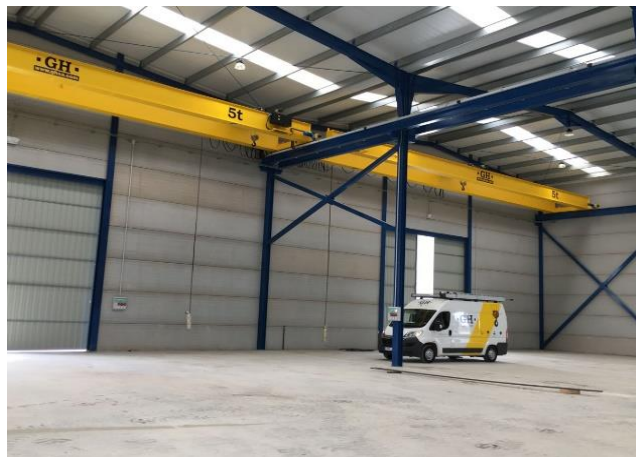
Ilustración 1 Infraestructura nave acondicionada (Fuente 1)
