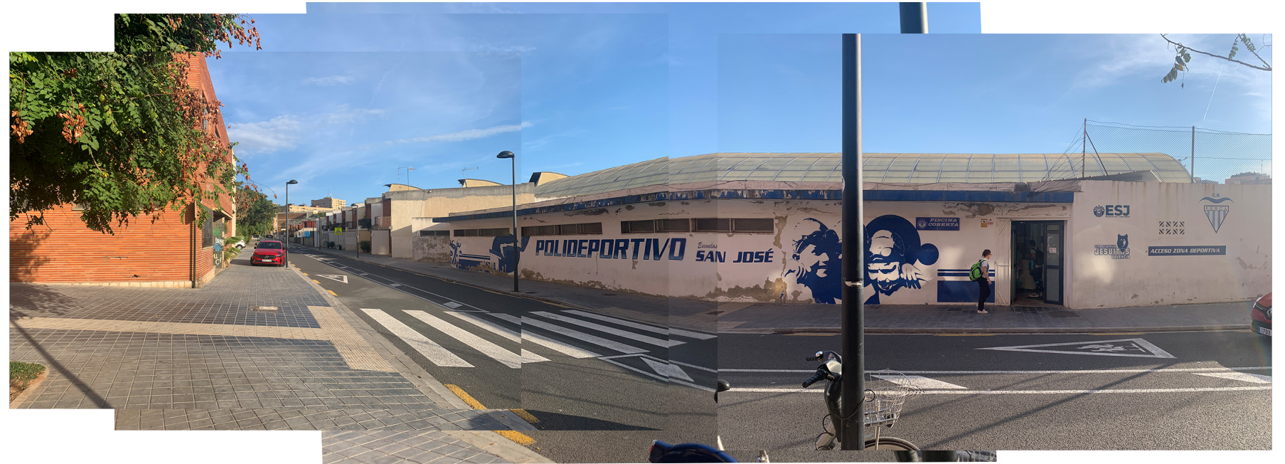
1. Vista de la fachada de la piscina de las Escuelas, junto a las viviendas.
