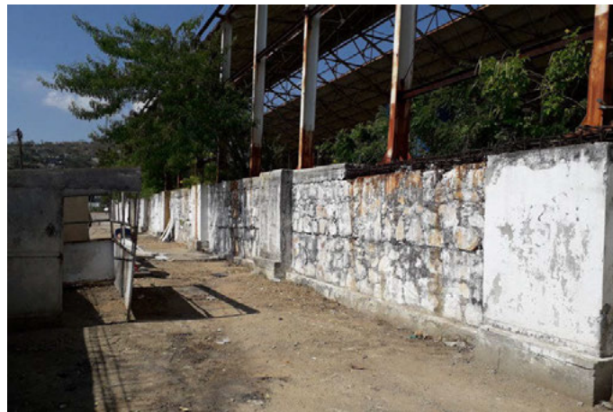
Fig. 6 Vista del muro de cimentación con grapas y cadena de arrastre de hormigón armado. Archivo de investigación del autor (2018)
