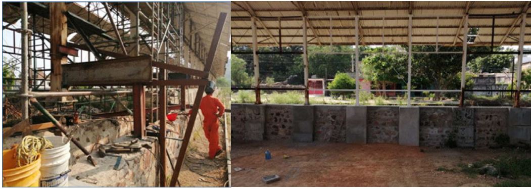
Fig.10 Estructura temporal durante los trabajos e intervención concluida. Archivo de investigación del autor (2019)
