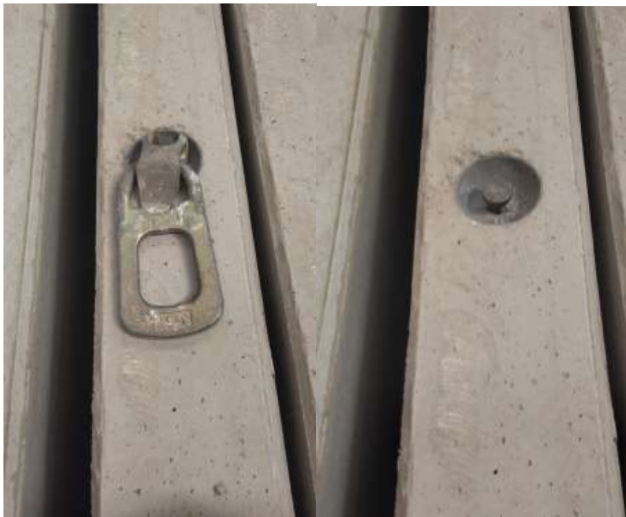
Ilustración 33. Rosca y garra de elevación. Fuente: Propia.
