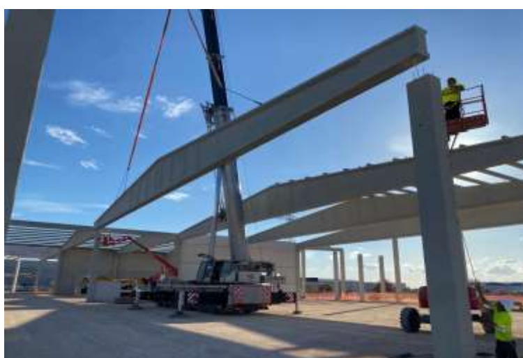
Ilustración 44. Izado de vigas de cubierta. Fuente: Propia.
