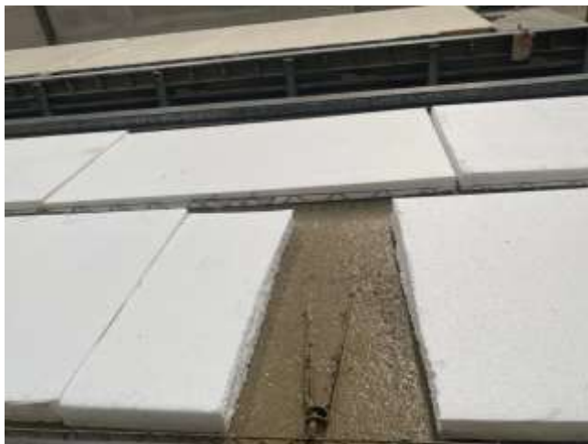
Ilustración 29. Hormigonado panel. Fuente: Propia.
