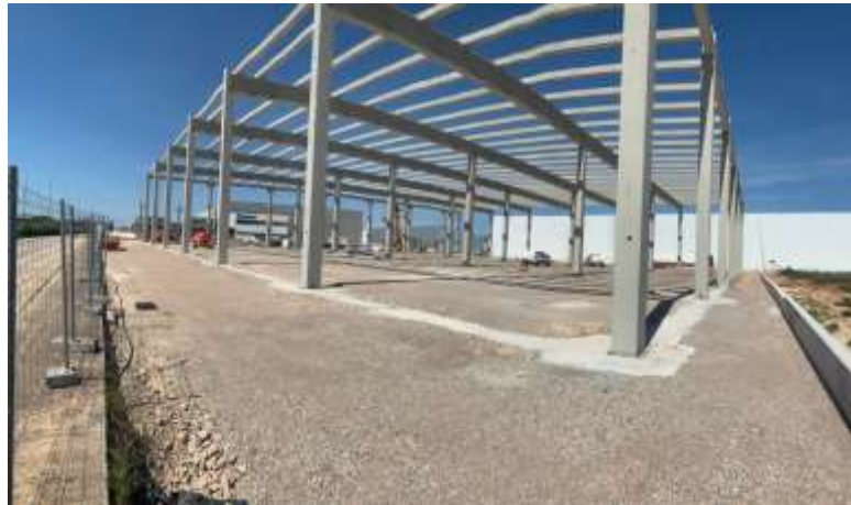
Ilustración 2. Estructura hormigón prefabricado. Fuente: Propia.
