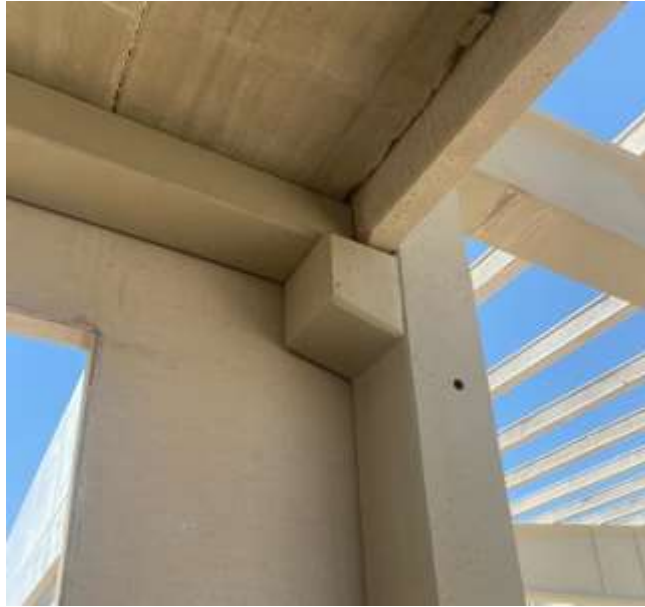
Ilustración 4. Ménsula-Viga. Fuente: Propia.
