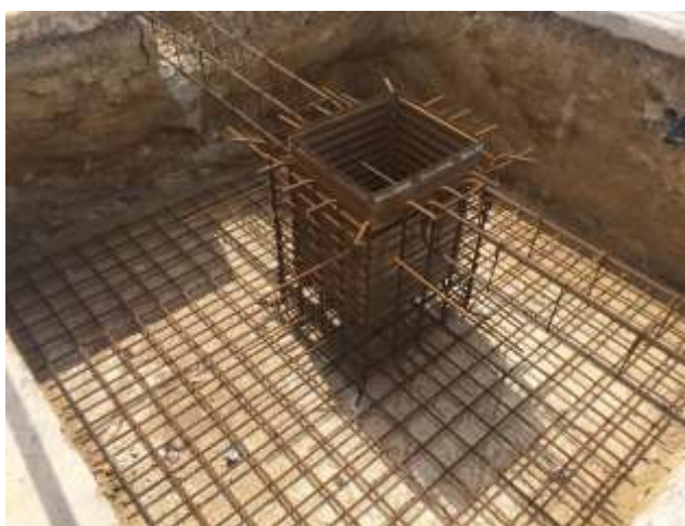
Ilustración 1. Cimentación por cáliz. Fuente: Propia.
