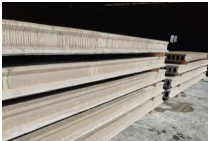
Ilustración 14. Acopio losas alveolares. Fuente: Propia.
