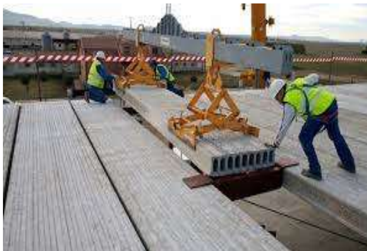
Ilustración 43. Izado de losa alveolar. Fuente: Propia.
