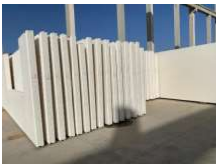
Ilustración 31. Acopio de paneles. Fuente: Propia.
