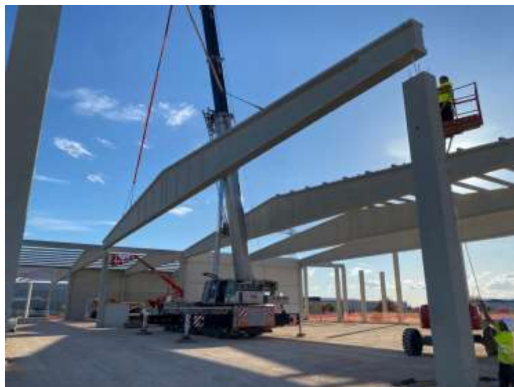
Ilustración 5. Viga delta. Fuente: Propia.
