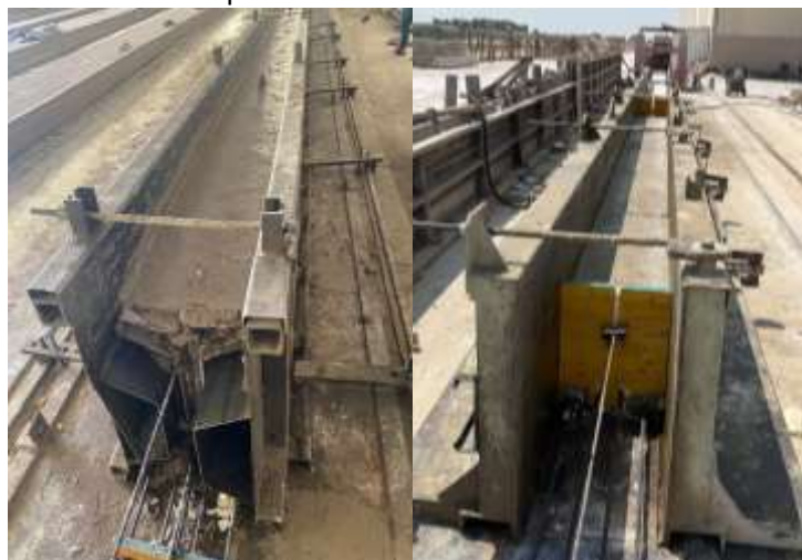
Ilustración 25. Hormigonado de viga. Fuente: Propia.
