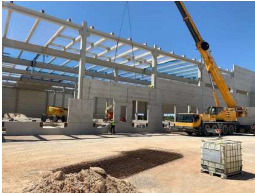
Ilustración 46. Colocación de paneles horizontales. Fuente: Propia.
