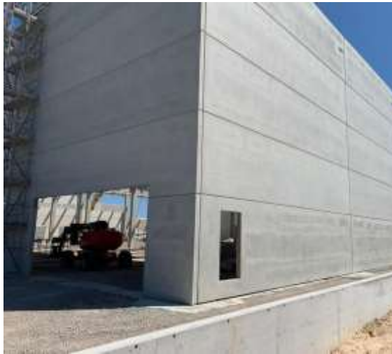
Ilustración 3. Paneles de hormigón. Fuente: Propia.
