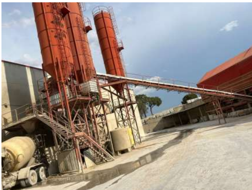
Ilustración 11. Instalación de hormigonado. Fuente: Propia.
