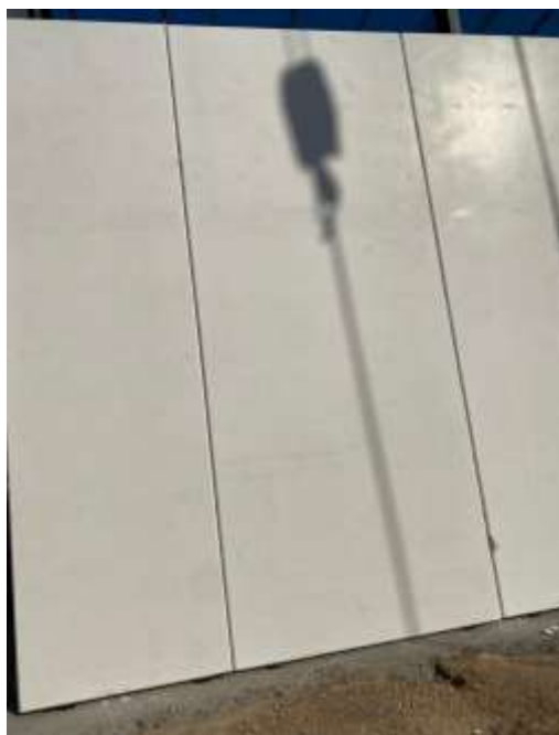
Ilustración 9. Paneles verticales. Fuente: Propia.
