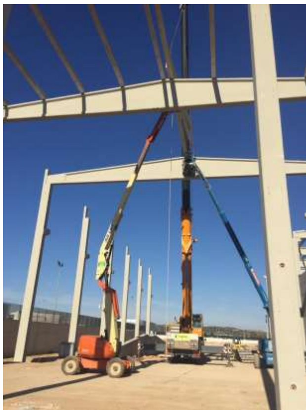
Ilustración 45. Colocación de correas. Fuente: Propia.
