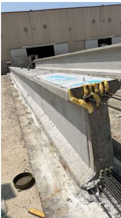
Ilustración 26. Desmoldeo viga. Fuente: Propia.
