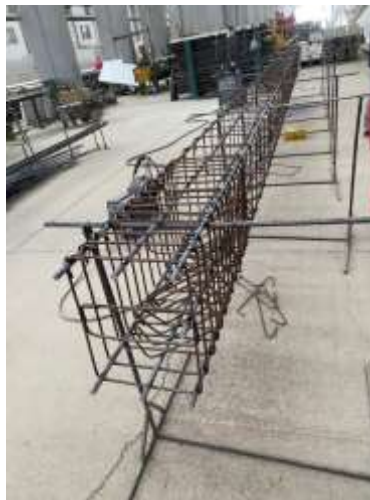
Ilustración 24. Caballetes para la armadura. Fuente: Propia.
