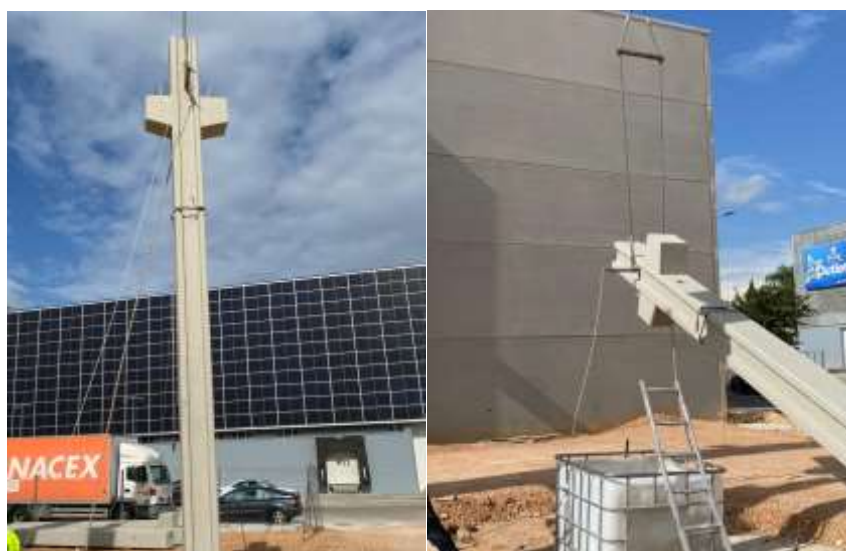
Ilustración 41. Izado de pilar con tubo pasante. Fuente: Propia.
