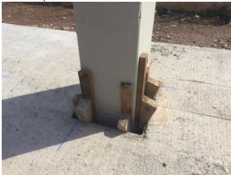
Ilustración 42. Cuñas para aplomo de pilar. Fuente: Propia.
