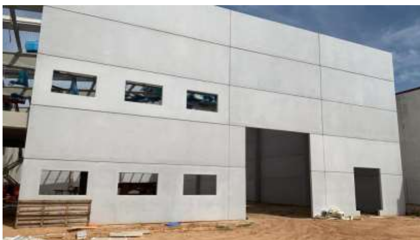
Ilustración 8. Paneles horizontales. Fuente: Propia.
