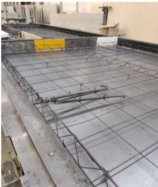
Ilustración 28. Armado de paneles. Fuente: Propia.
