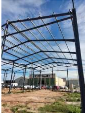
Ilustración 1. Estructura metálica. Fuente: Propia.
