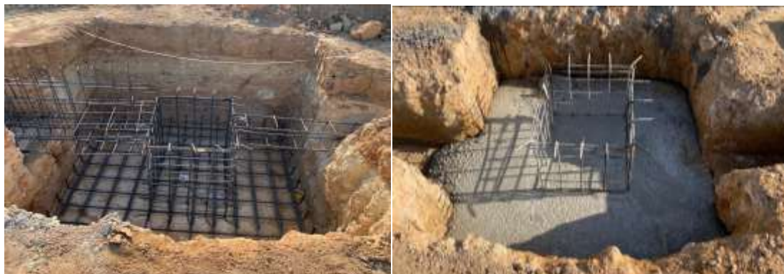
Ilustración 39. Armado y hormigonado de cimentación. Fuente: Propia.
