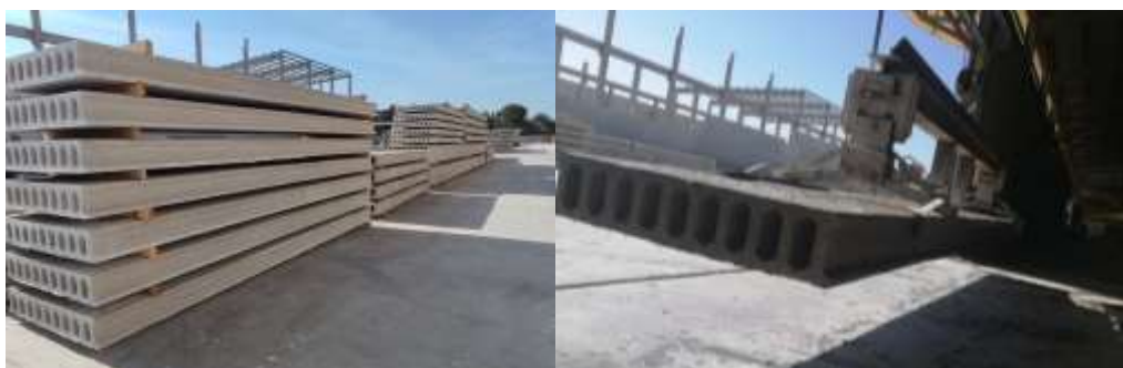
Ilustración 22. Acopio y pinzas para transporte de losas alveolares.
