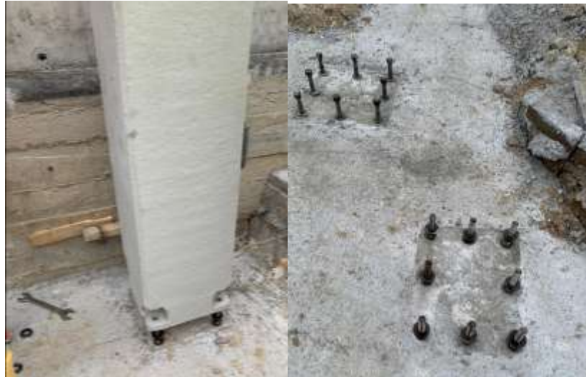
Ilustración 2. Cimentación atornillada. Fuente: Propia
