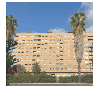
Tipología edificatoria. Avenida de las Cortes Valencianas
