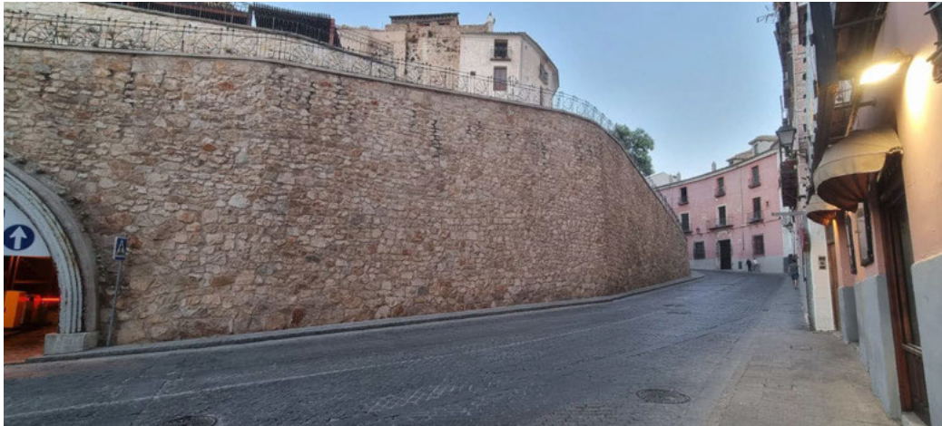
Fig. 1 Fotografía actual de la calle Alfonso VIII y del muro de contención de la calle Zapaterías
