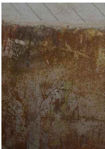
Figura 28. Abrasión de la película pictórica.
