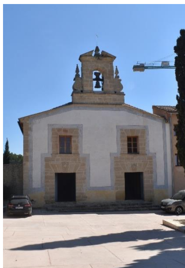
Figura 1. Vista de la fachada principal de la Iglesia del Convento de San Francisco.
