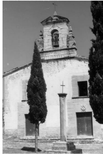
Figura 7. Vista de la fachada principal de la Iglesia en los años 70. Fotografía de Mario Guillamón Vidal.
