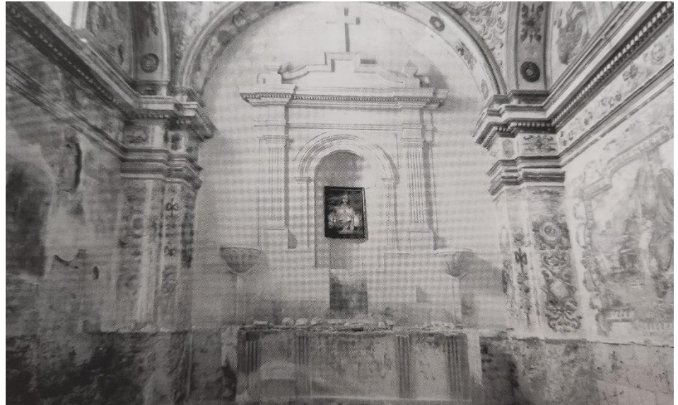
Figura 9. Capilla del Ecce-Homo en 2011, antes del inicio de su restauración. Fotografía de Luis Cortés.
