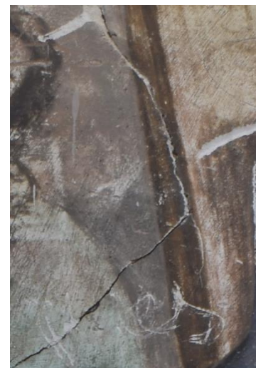
Figura 36. Grieta que recorre de extremo a extremo la pintura mural.
