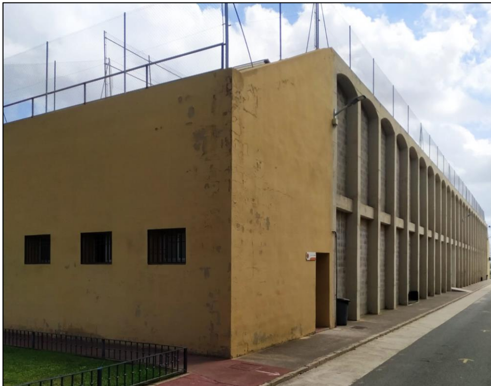
FIGURA 12. EDIFICIO DEL TRINQUET (VESTUARIOS SITUADOS EN LOS EXTREMOS).
