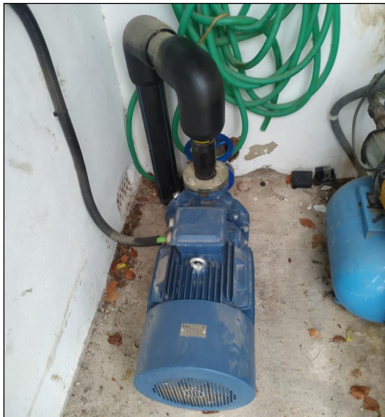
FIGURA 22. BOMBA PARA RIEGO CAMPO DE FÚTBOL.
