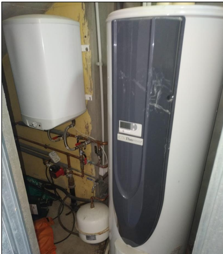
FIGURA 17. TERMO ELÉCTRICO Y ACUMULADOR VESTUARIO TRINQUET 1.
