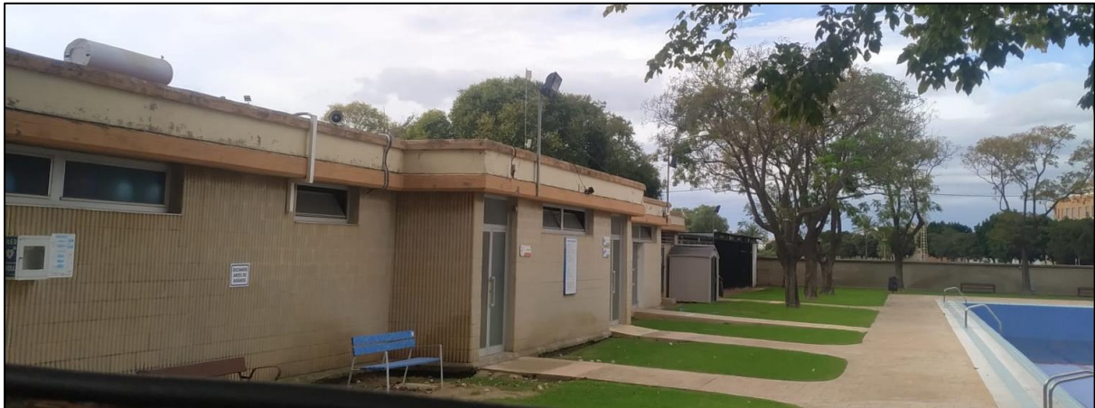
FIGURA 9. VESTUARIOS PISCINA Y SALAS DE MÁQUINAS ADYACENTES.
