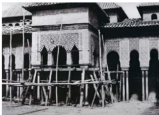
Fig. 32 Inicio de las obras, andamiado en el templete oriental. Se reforzará su cimentación en 1859. G de Beaucorps, 1858 27 La inestabilidad de la estructura ya era evidente justo antes de la restauración que empeoraría su situación
