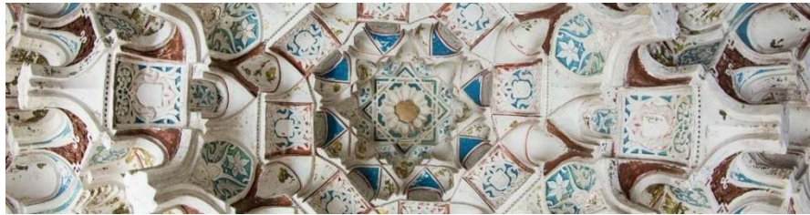
Fig. 82 Detalle de la gran bóveda de mocárabes del Palacio de Dos Hermanas donde se aprecian los diferentes colores originales dispuestos 55
