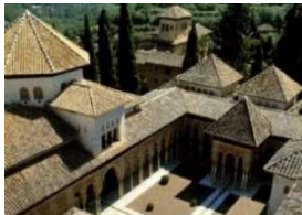
Fig. 55 37 Doce cubiertas piramidales echando aguas unas contra otras. Concepto muy alejado de la idea de expulsión de aguas pluviales nazarí que vemos en todo el complejo.
