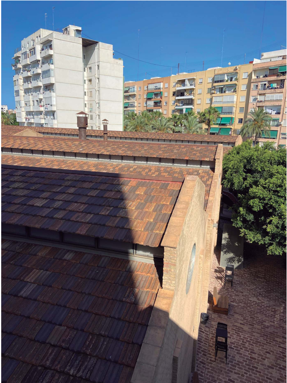
Fotografía aérea cubierta fachada patio de acceso a Bombas Gens. Fuente de elaboración propia.
