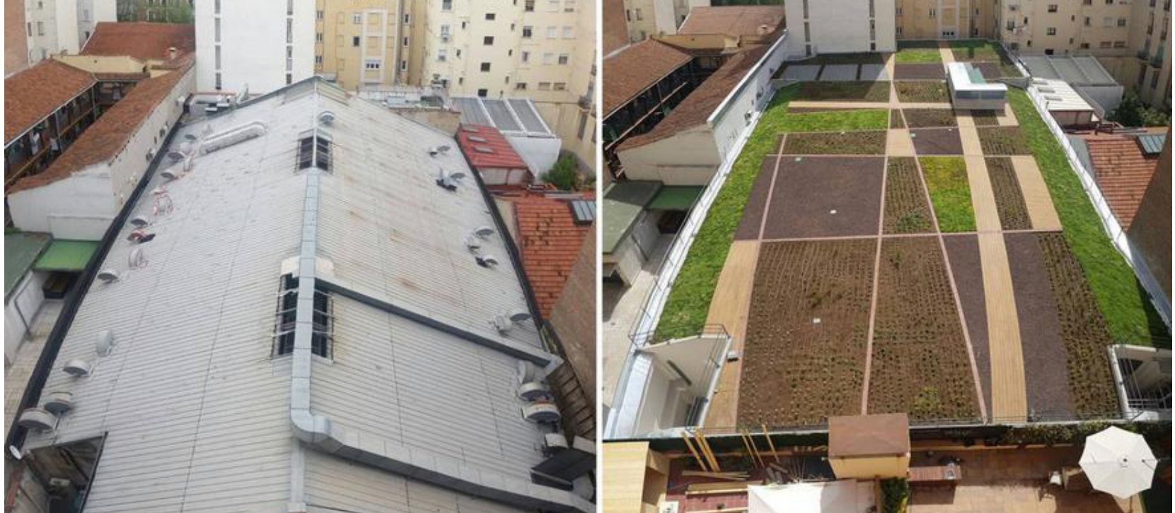
Fig 3.6 Transformación del edificio Mercadona Bravo Murillo, Madrid
