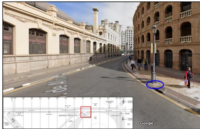
Figura 40. Vista de calle de la arqueta de red de alumbramiento
