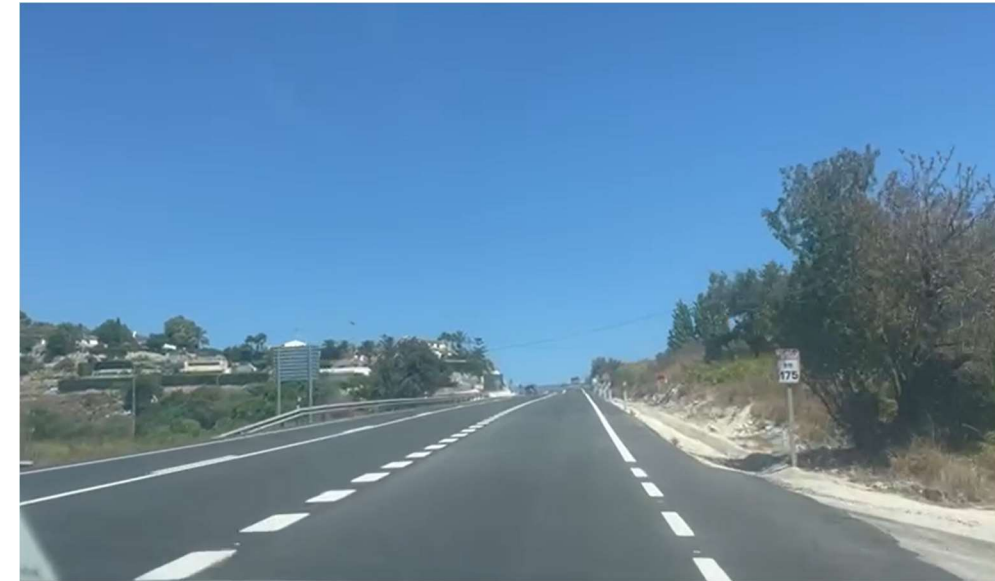
Figura 26. Señal S-572 en el p.k. 175+000 (Fuente: Elaboración propia)
