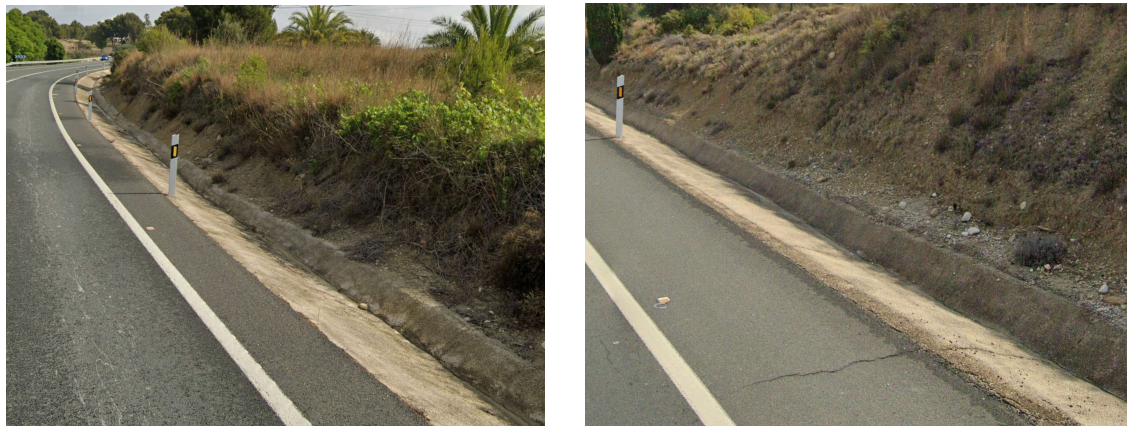
Figura 26. Cunetas entre el p.k. 172+376 y el p.k. 172+430 del tramo de estudio (Fuente: Elaboración propia)
