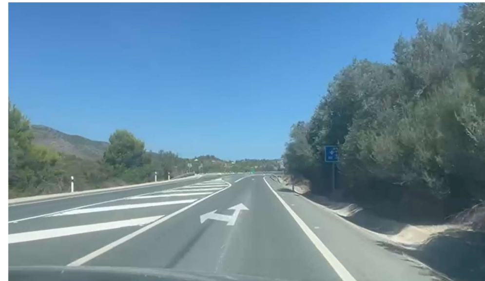
Figura 7. Señal S-22 oculta parcialmente por la vegetación en el p.k. 172+407, sentido creciente (Fuente: Elaboración propia)
