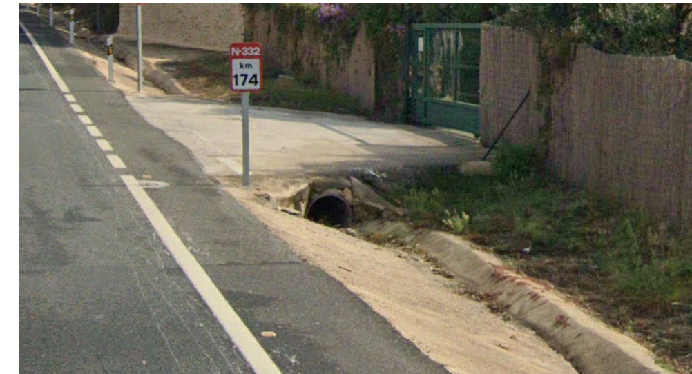
Figura 28. Paso salvacuneta en el p.k. 174 del tramo de estudio (Fuente: Elaboración propia)
