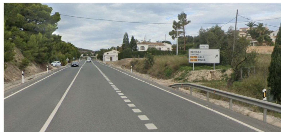
Figura 10. Señal S-245 en el p.k. 174+280 del tramo de estudio (Fuente: Elaboración propia)
