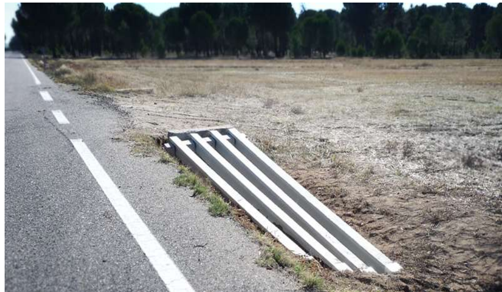
Figura 4. Dispositivo para protección de paso salvacuneta (Fuente: Cidro)
