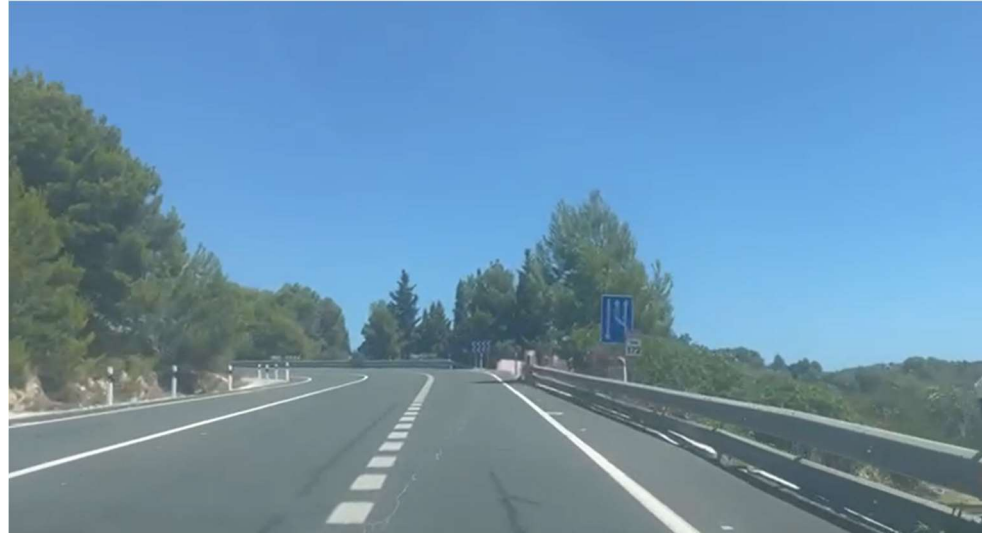
Figura 4. Señal S-572 en el p.k. 172+000, sentido creciente (Fuente: Elaboración propia)
