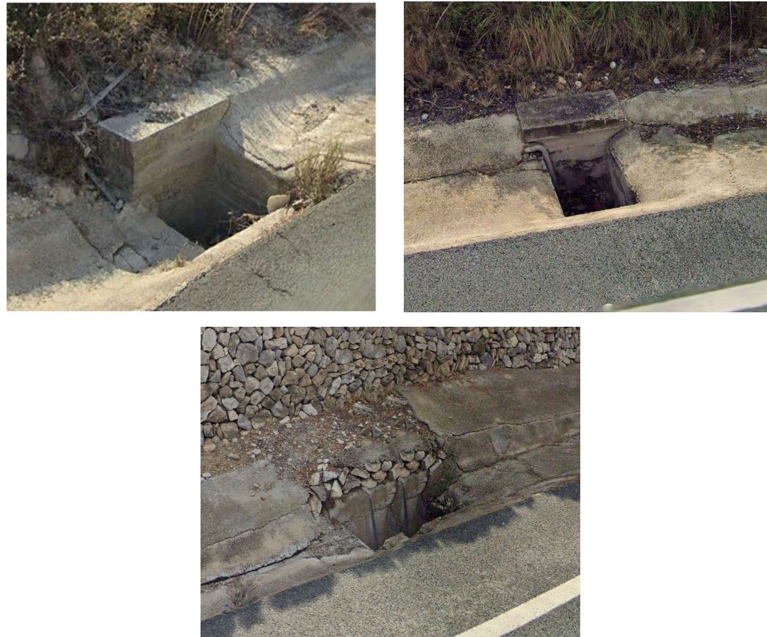
Figura 30. Arquetas en el p.k. 172+358, en el p.k. 173+931 y en el p.k. 174+363 del tramo de estudio (Fuente: Elaboración propia)
