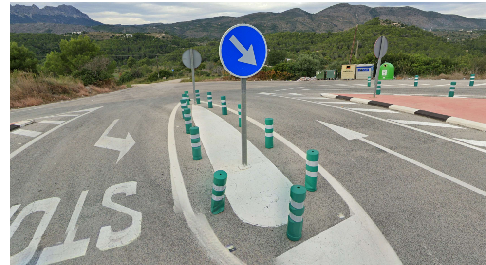
Figura 2. Señal R-401a en el p.k. 172+507 del tramo de estudio (Fuente: Elaboración propia)
