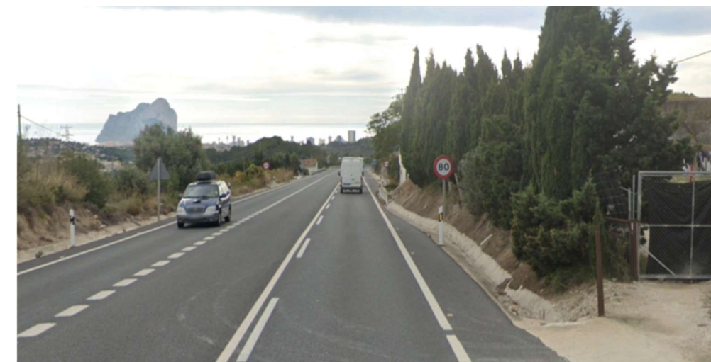
Figura 5. Señal R-301 en el p.k. 173+747 del tramo de estudio (Fuente: Elaboración propia)
