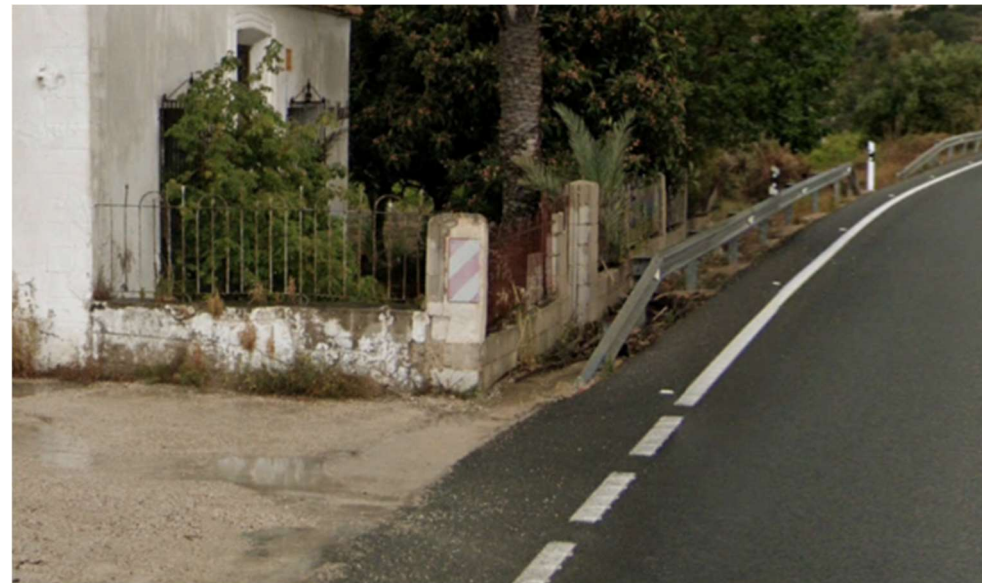
Figura 22. Baliza plana en el p.k. 174+772 del tramo de estudio (Fuente: Elaboración propia)
