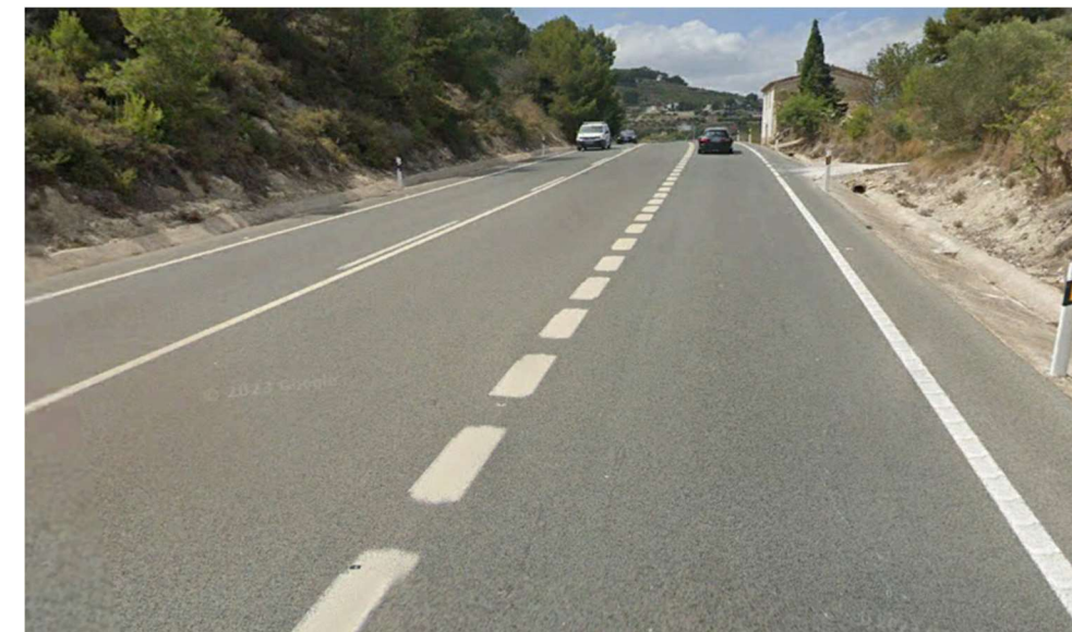
Figura 4. Visibilidad de parada entre el p.k. 174+535 y el p.k. 174+565 del tramo de estudio (Fuente: Elaboración propia)
