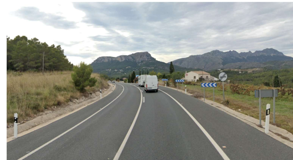
Figura 9. Señal R-502 en el p.k. 173+125 del tramo de estudio (Fuente: Elaboración propia)
