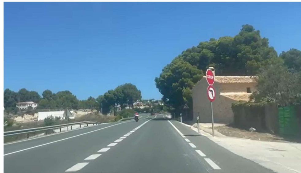
Figura 17. Edificio en los márgenes de la N-332 en el p.k. 174+038, sentido creciente (Fuente: Elaboración propia)
