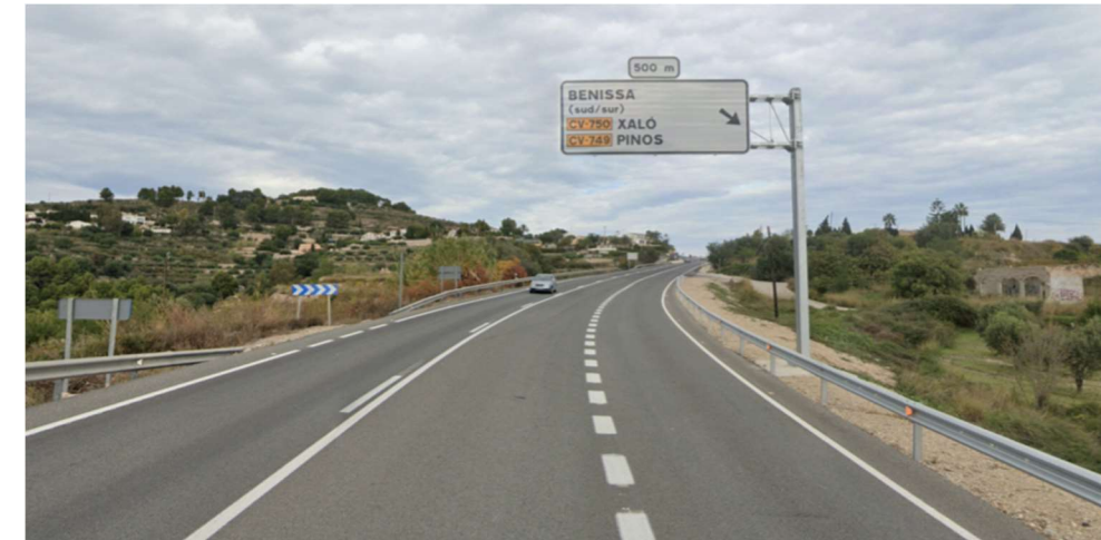
Figura 11. Señal S-245 en el p.k. 174+882 del tramo de estudio (Fuente: Elaboración propia)
