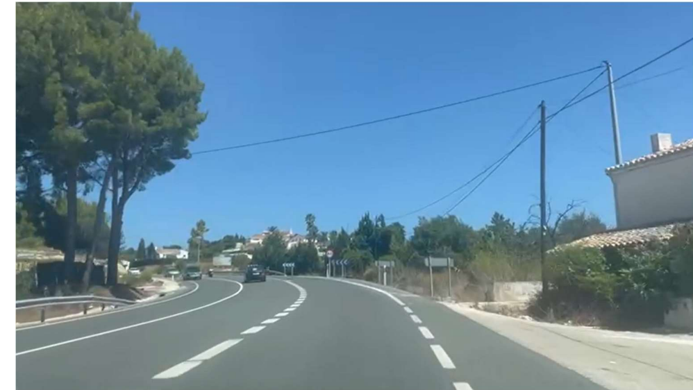
Figura 18. Curva en el p.k. 174+158, sentido creciente (Fuente: Elaboración propia)
