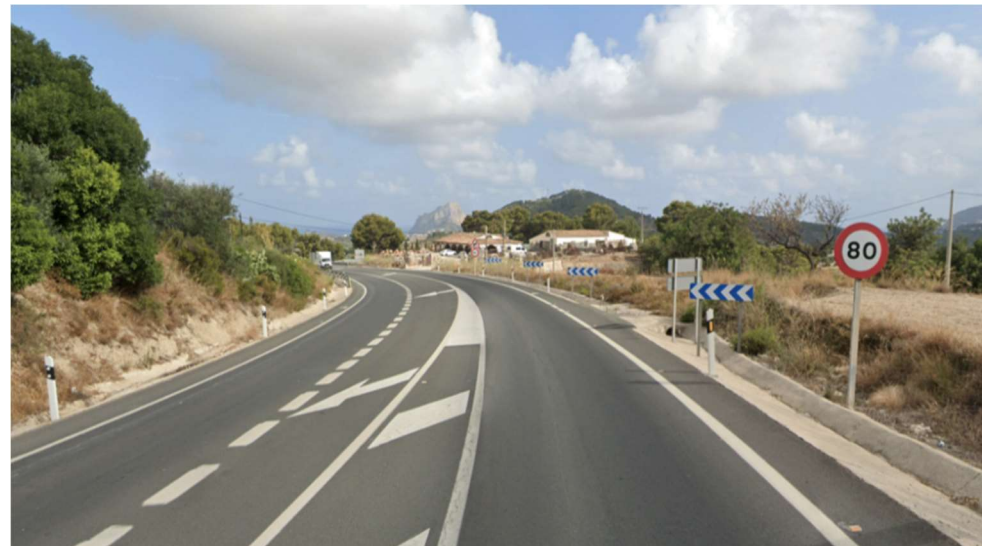
Figura 6. Señal R-301 en el p.k. 172+297 del tramo de estudio (Fuente: Elaboración propia)
