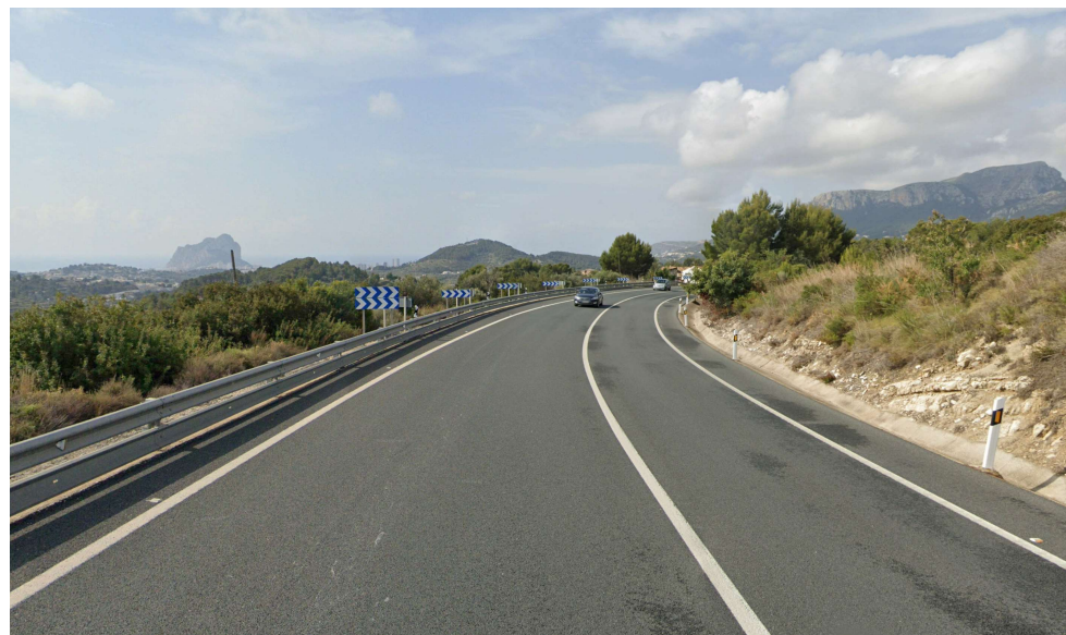
Figura 25. Balizamiento de la curva en el p.k. 173+465 del tramo de estudio (Fuente: Elaboración propia)
