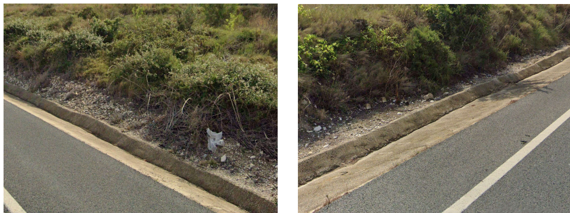
Figura 27. Cunetas entre el p.k. 172+547 y el p.k. 172+674 del tramo de estudio (Fuente: Elaboración propia)
