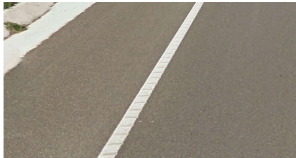
Figura 20. Bandas longitudinales con resalto en el p.k. 172+726 del tramo de estudio (Fuente: Elaboración propia)
