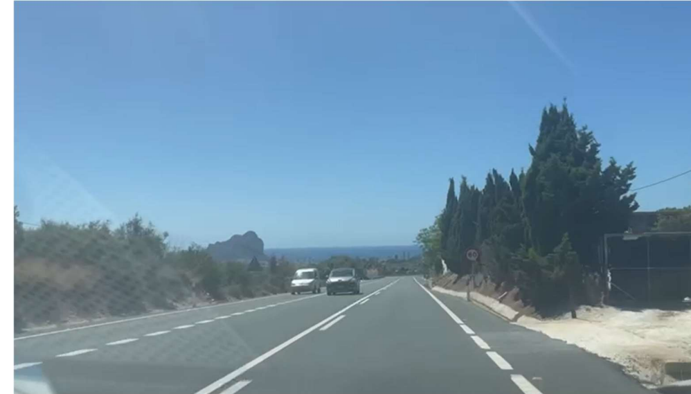
Figura 14. Señal R-301 oculta parcialmente por la vegetación en el p.k. 173+747, sentido creciente (Fuente: Elaboración propia)
