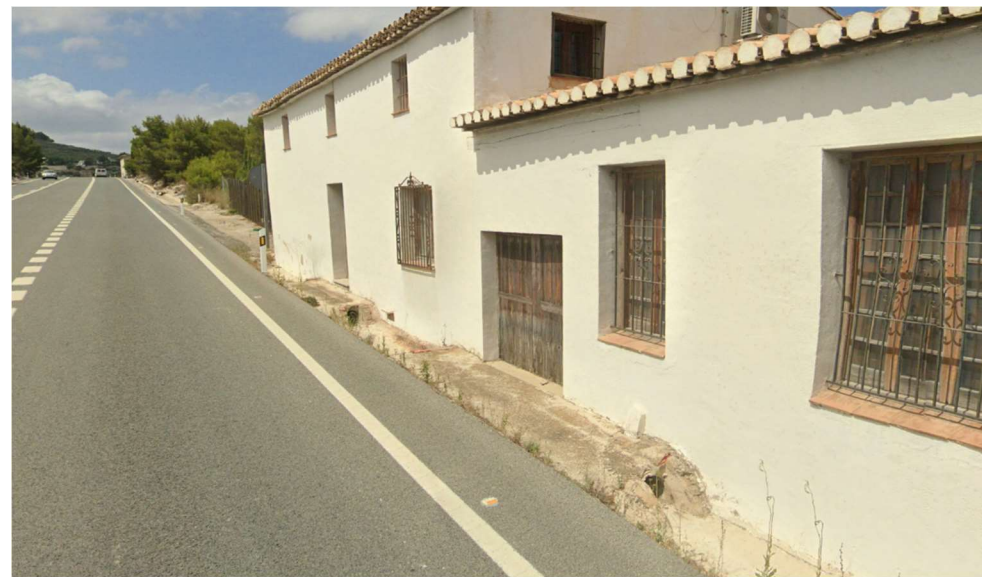
Figura 3. Arcén en el p.k. 174+435 del tramo de estudio (Fuente: Elaboración propia)
