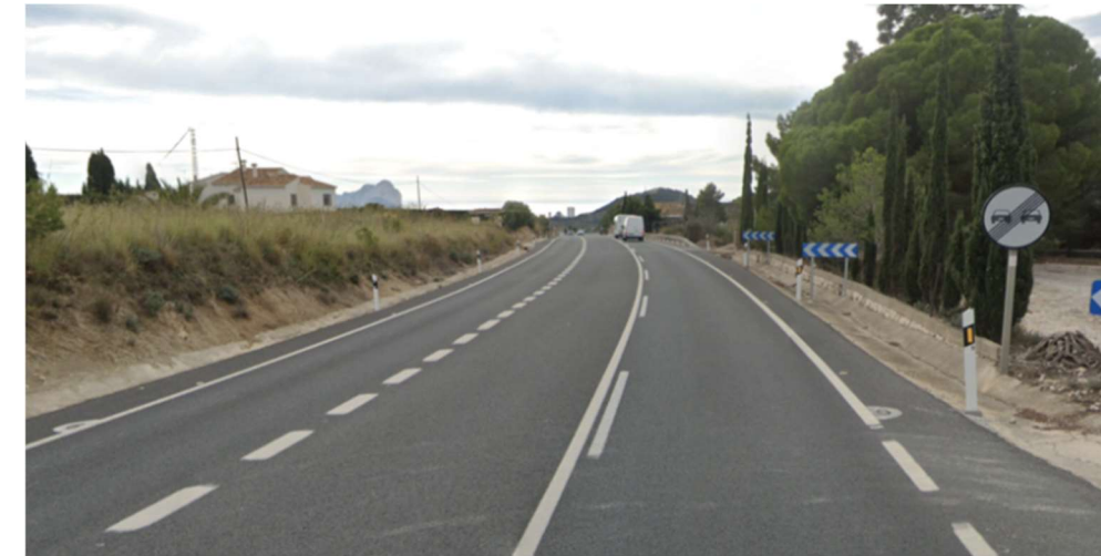
Figura 15. Indicación del fin de la prohibición de adelantamiento en el p.k. 173+878 del tramo de estudio (Fuente: Elaboración propia)
