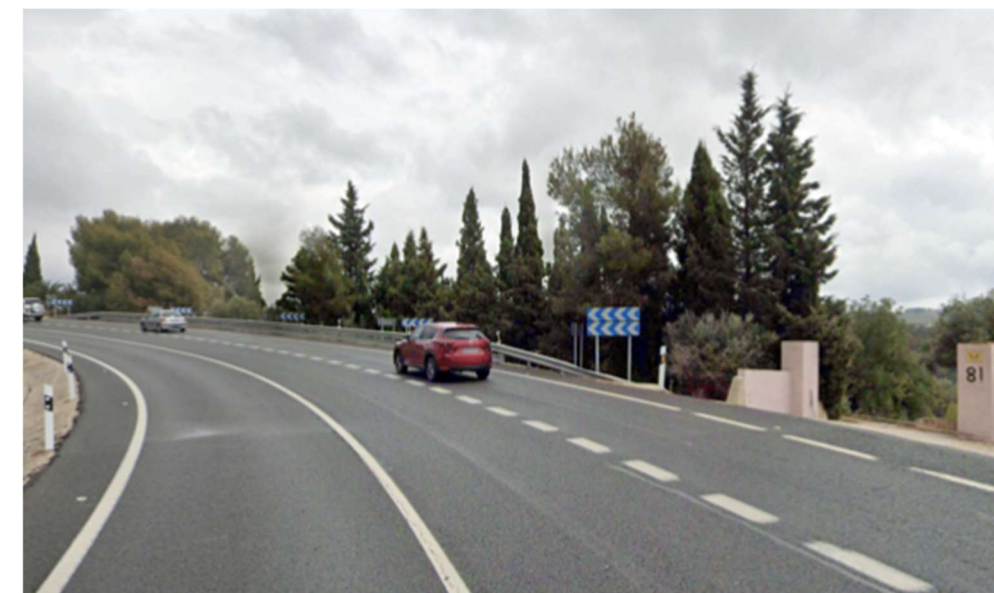
Figura 23. Balizamiento de la curva en el p.k. 172+144 del tramo de estudio (Fuente: Elaboración propia)
