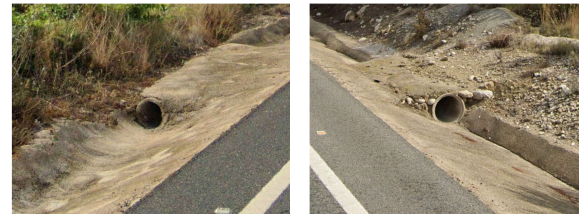
Figura 29. Tubos pasacunetas en el p.k. 173+645 y en el p.k. 174+501 del tramo de estudio (Fuente: Elaboración propia)
