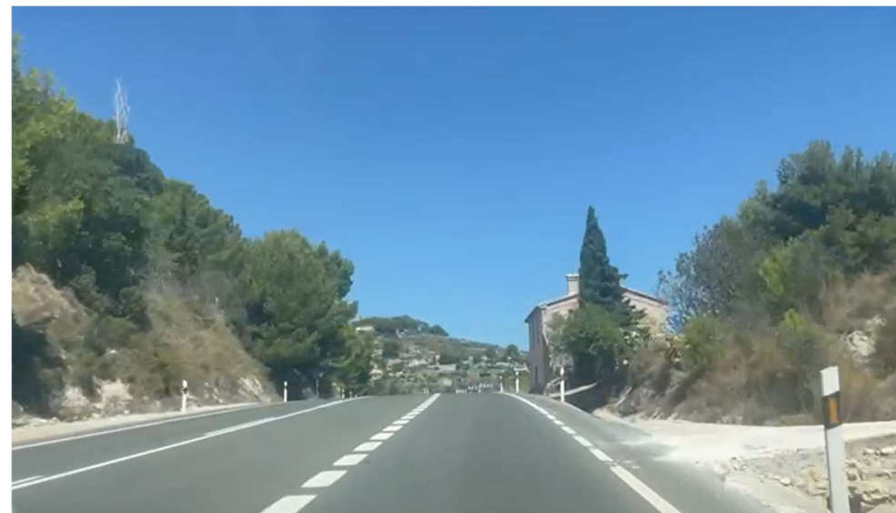
Figura 21. Curva en el p.k. 174+575, sentido creciente (Fuente: Elaboración propia)
