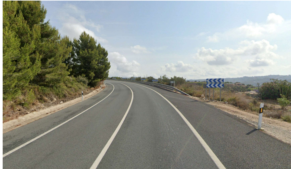
Figura 24. Balizamiento de la curva en el p.k. 173+340 del tramo de estudio (Fuente: Elaboración propia)
