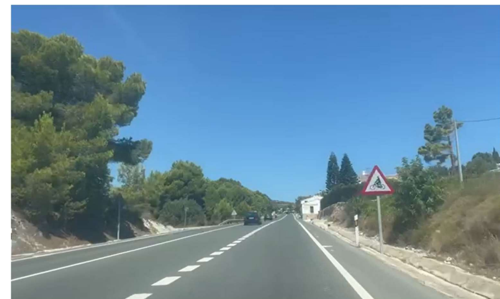
Figura 19. Señal P-22b en el p.k. 174+295, sentido creciente (Fuente: Elaboración propia)
