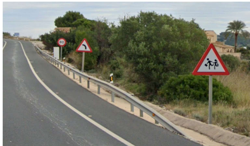
Figura 1. Posición longitudinal de P-21, P-13b y R-301 en el tramo de estudio (Fuente: Elaboración propia)
