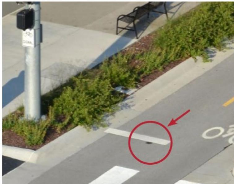
Figura 36: Radar en pavimento en Lincoln, Nebraska. (Fuente [15]).
