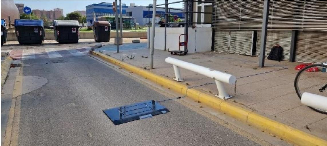
Figura 34: Espira magnética doble para la detección de VMP. (Fuente [23]).
