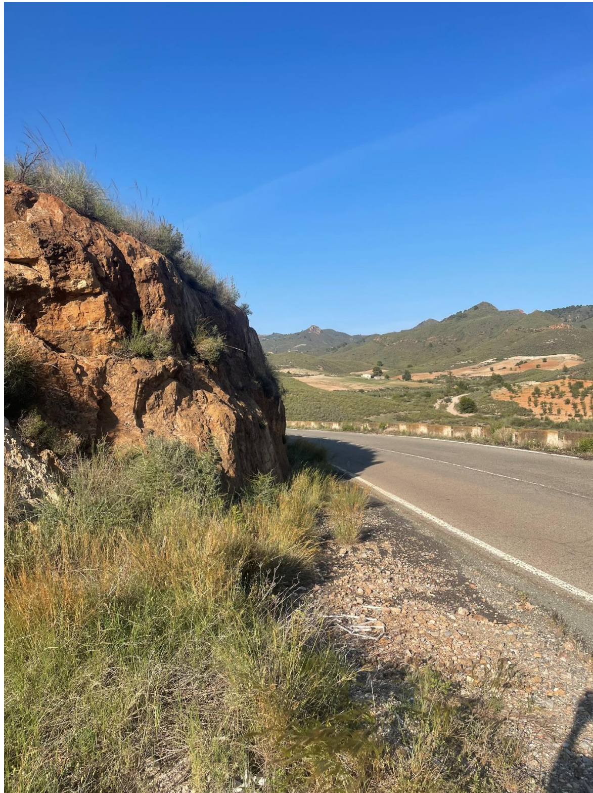
Figura 6. Talud vertical en la margen derecha. Fuente: Elaboración propia
