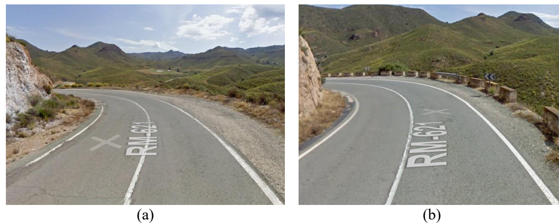
Figura 13. Curvas con visibilidad reducida en sentido decreciente de PKs (a) PK 1+620 y (b) PK 1+420. Fuente: Elaboración propia
