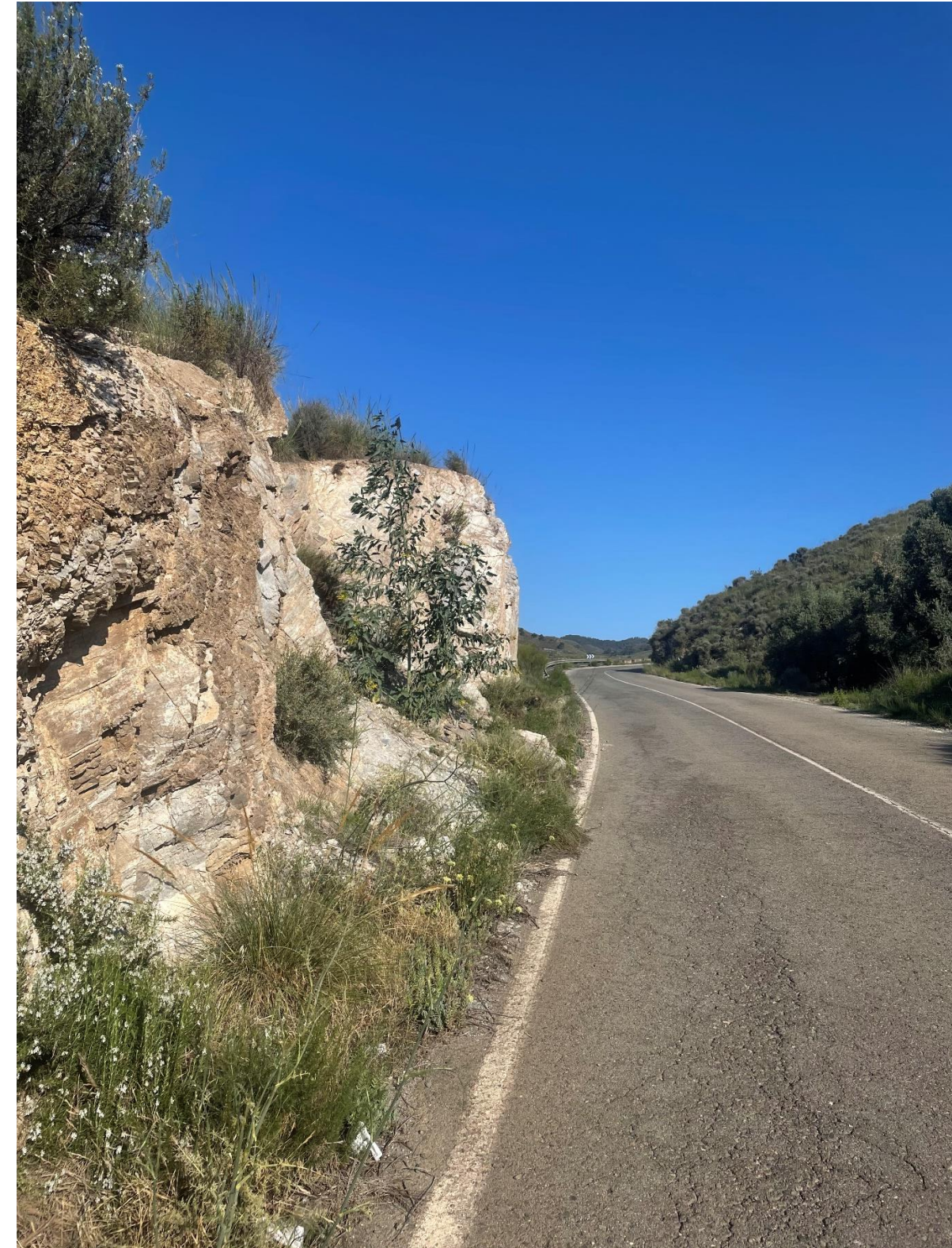
Figura 5. Taludes verticales en la margen izquierda. Fuente: Elaboración propia
