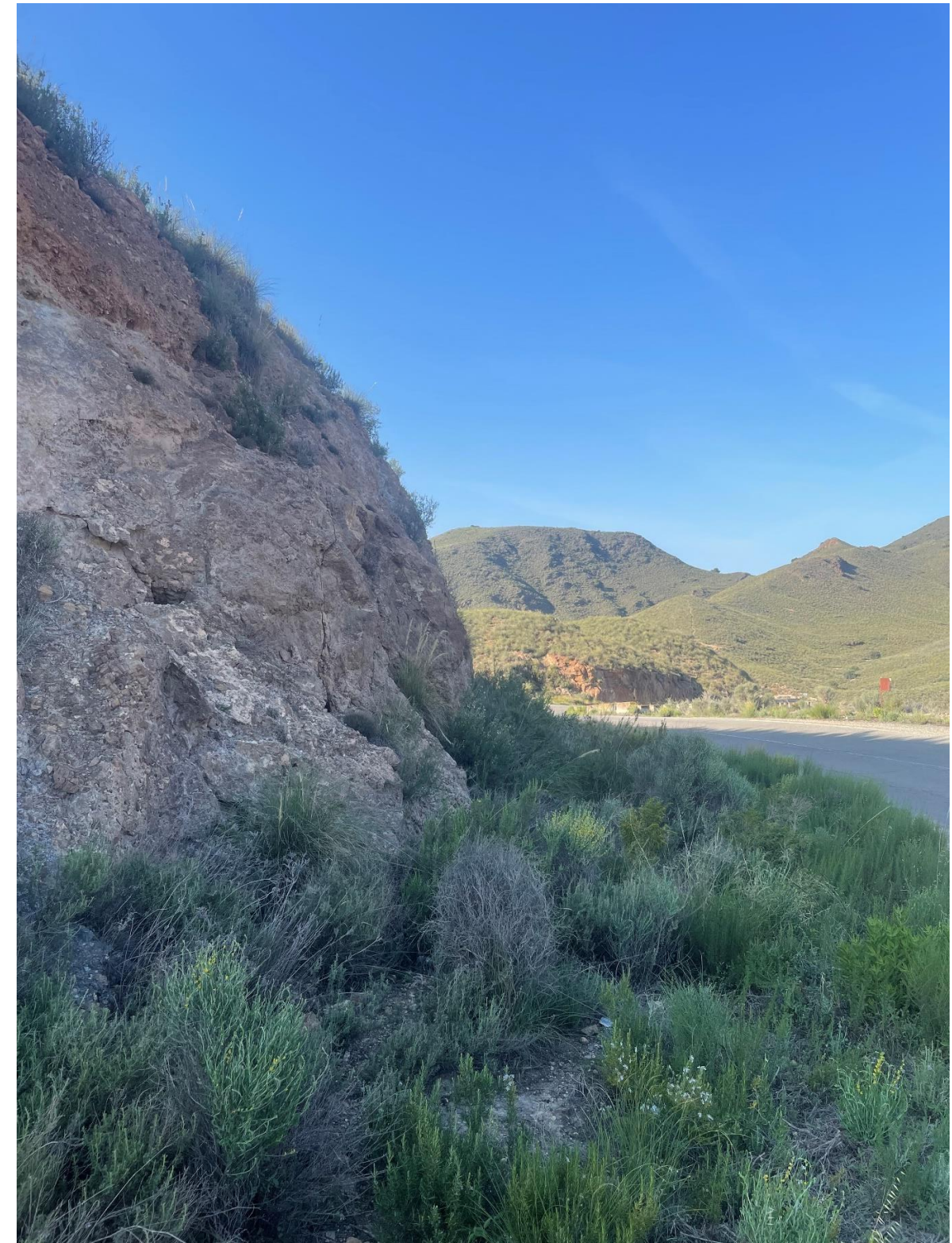
Figura 7. Talud subvertical en la margen derecha. Fuente: Elaboración propia
