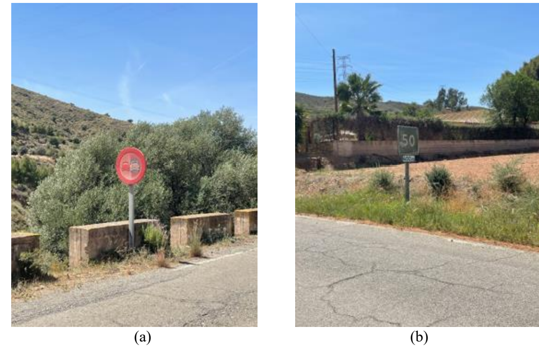
Figura 9. Señales de tráfico (a) prohibido adelantar y (b) velocidad recomendada en mal estado. Fuente: Elaboración propia
