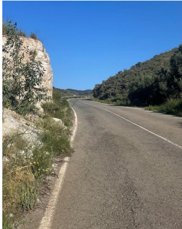
Figura 7. Talud vertical sin patologías. Fuente: Elaboración propia
