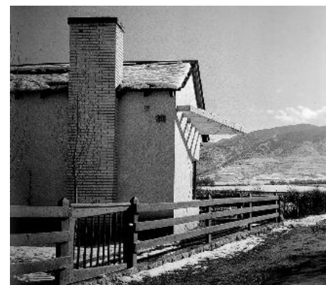
Figura 36. Pérgola como extensión espacial ubicada en el volumen de sala de estar.
