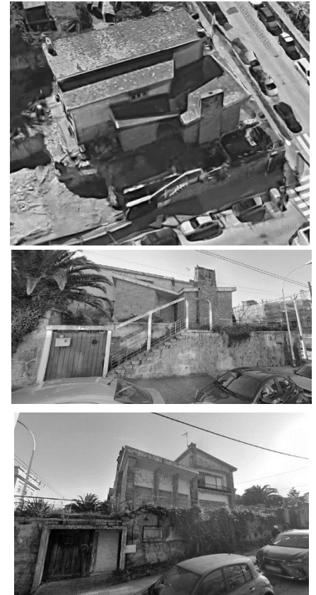
Fig.93 Fotografías actuales del estado de la vivienda.
