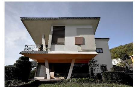
Fig.98 Salvando la depuración de estilo, las dos construcciones cuentan con elementos comunes que ayudan a establecer una continuidad entre ambas.
