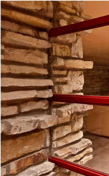
(44) Detalle del encuentro de la carpintería con el muro. (Imagen de Fallingwater)
