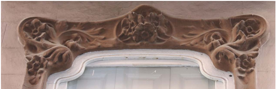
Figure 6. Window decoration. Casa Roglà. Calle Bordadores, 1. Valencia. Source: (Burguete 2017)
