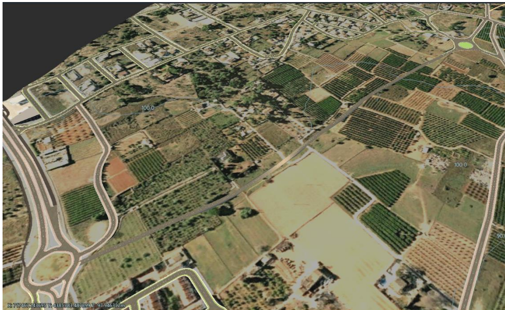
Figura 50. Vista aérea del trazado desde el inicio del tramo 1.
