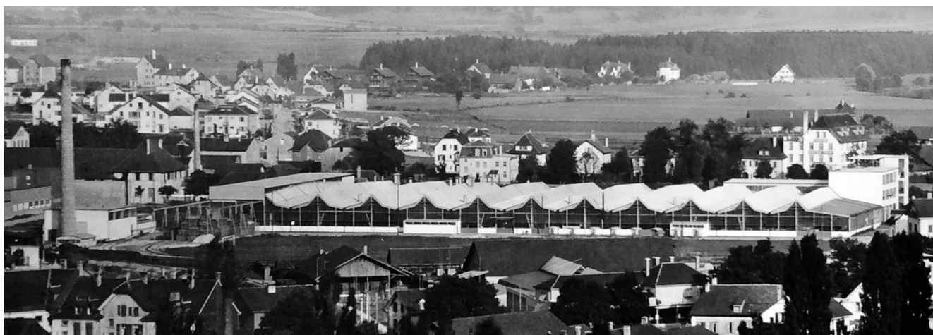
Figura 1. La fábrica de ensamblaje General Motors en Biel. Fuente: Steiger, R. y Hubacher, C. (1937). Automontagefabrik der General Motors Suisse S.A., Biel. Schweizerische Bauzeitung , 109/110 (16).
