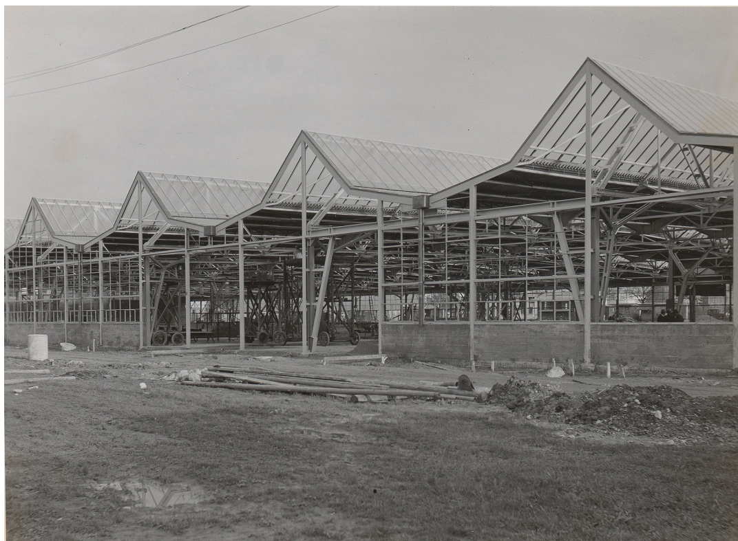
Figura 9. Imagen de las cerchas en construcción (imagen inédita). Fuente: gta Archives / ETH Zurich, Haefeli Moser Steiger.
