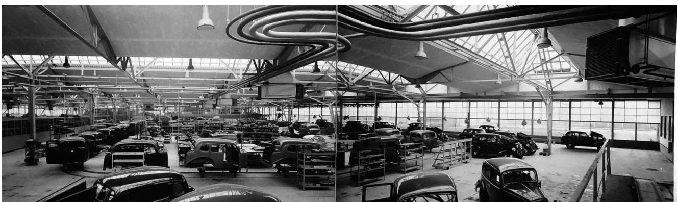
Figura 6. Imagen del interior de la nave de ensamblaje. Fuente: Steiger, R. y Hubacher, C. (1937). Automontagefabrik der General Motors Suisse S.A., Biel. Schweizerische Bauzeitung , 109/110 (16).
