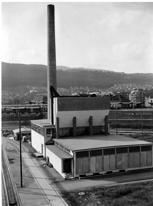
Figura 11. Imagen exterior de la central eléctrica. Fuente: Steiger, R. y Hubacher, C. (1937). Automontagefabrik der General Motors Suisse S.A., Biel. Schweizerische Bauzeitung , 109/110 (16).
