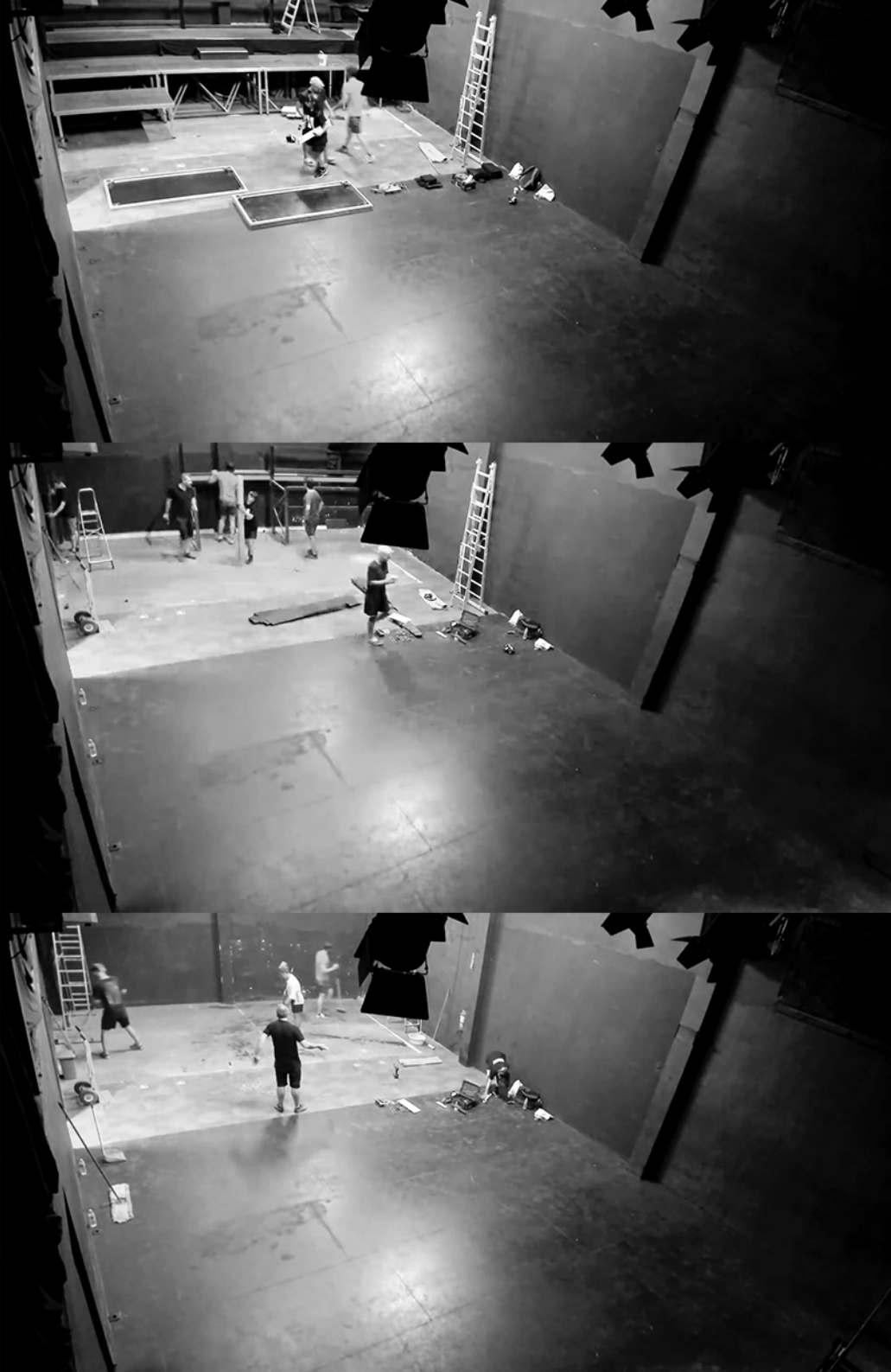
FIGURA 205. Proceso de desmontaje de gradas y nivelación del suelo para instalar la pista de hielo de «SOL», 2022.
