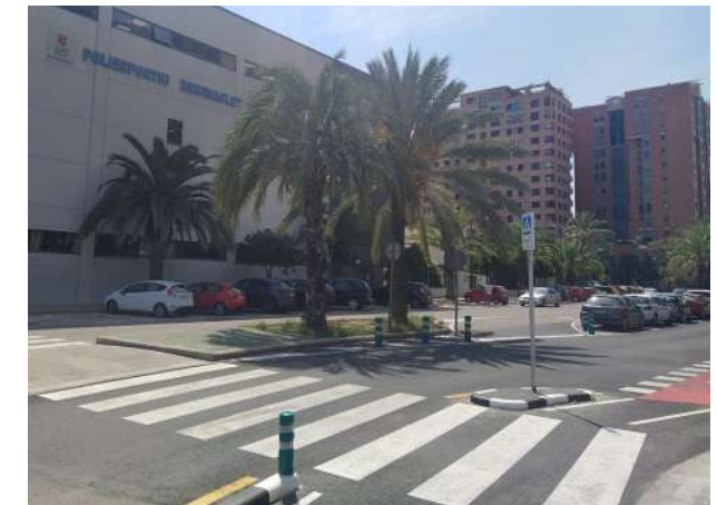
Fig. 64. Acceso al Polideportivo Municipal.
