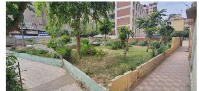
Fig. 34. Espacios con falta de mantenimiento y de difícil supervisión encontrados en una de las escuelas del estudio.
