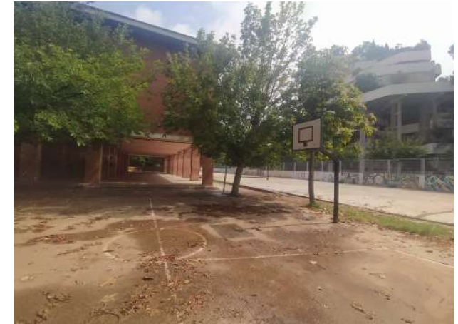
Fig. 67. Zona cubierta del patio de Primaria del CEIP Pare Catalá.
