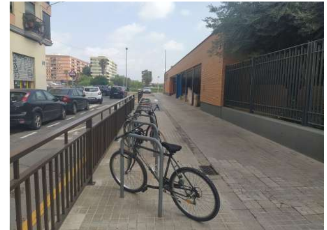
Fig. 53. Ampliación en acera para las entradas al colegio con estacionamientos para bicicletas y patinetes,
