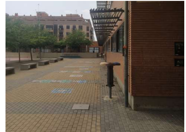
Fig. 56. Dispositivos de protección solar en la fachada sur del patio de CEIP Municipal Benimaclet.
