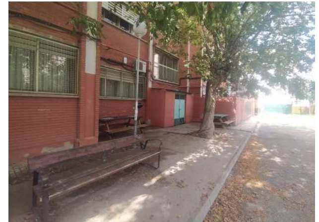
Fig. 72. Punto ciego al Norte del edificio del CEIP Pare Catalá.
