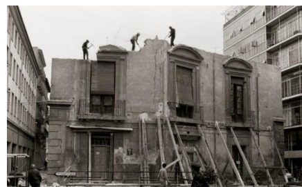
[Fig. 11] Derribo del Palacete del Doctoral de la Riva, 1970-1980.
