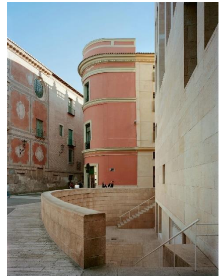
[Fig. 34] Vista del foso desde calle Frenería. Se puede apreciar como la esquina del edificio del ayuntamiento hace acto de presencia en el conjunto de la plaza del Cardenal Belluga.
