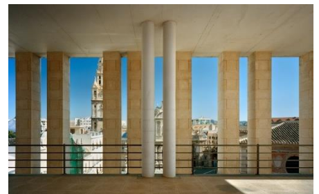
[Fig. 19] Duplicación de pilares en la estructura del edificio, en la fachada libre y en el imafrente de la Catedral.
