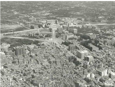
[Fig. 5] Imagen de la ciudad de Murcia de la primera mitad del siglo XX. La huerta está en contacto directo con la ciudad y aún no se había producido la gran expansión urbanística. Aún estaba sin edificar las inmediaciones de la Plaza Circular y la estación del tren llegaba hasta allí.
