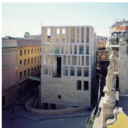
[Fig. 60] Vista de la fachada de la Ampliación del Ayuntamiento de Murcia desde la azotea de uno de los edificios modernistas que vuelcan a la Plaza. En esta imagen se puede apreciar la polémica pasarela que conectaba ambos edificios.
