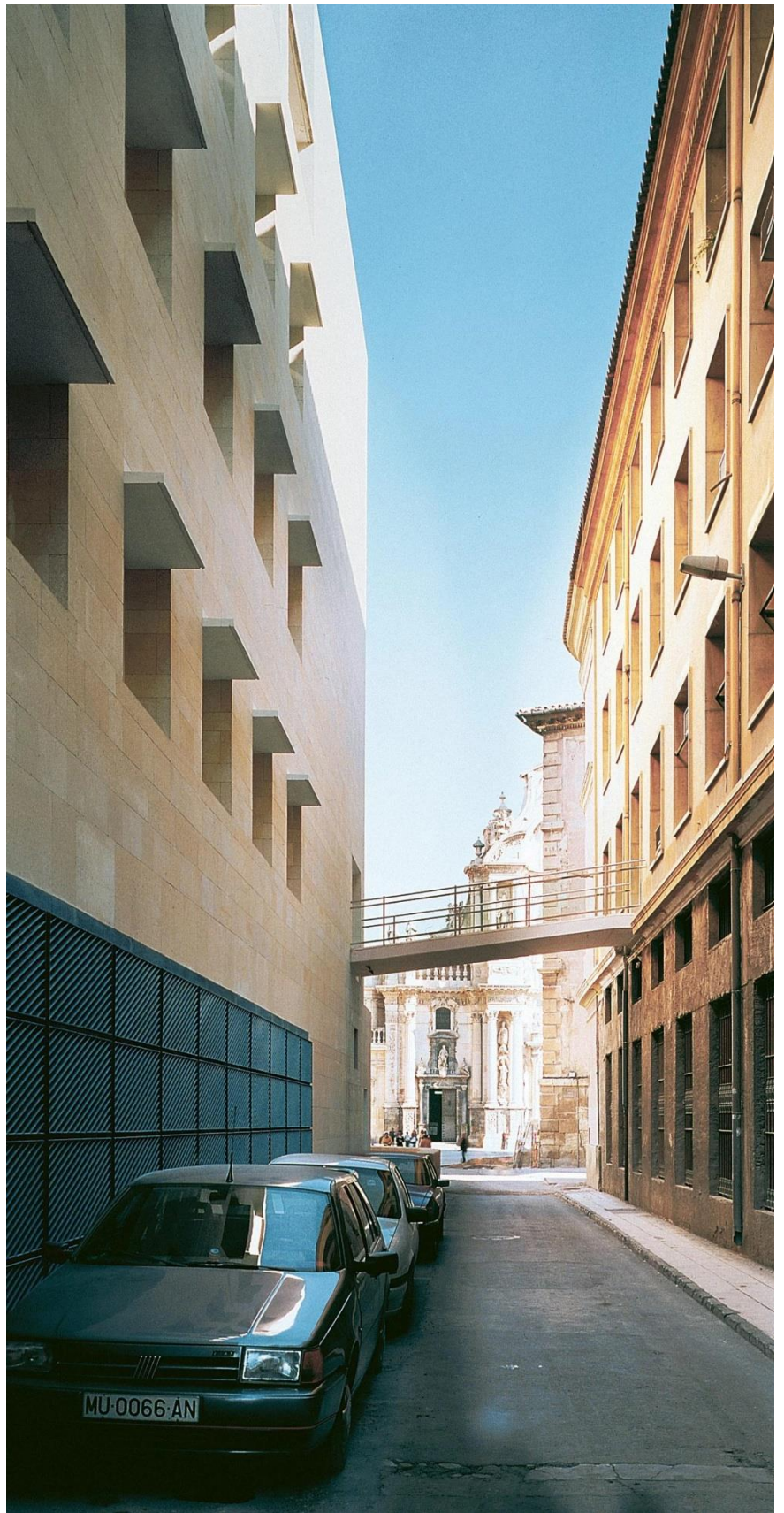
[Fig. 41] Vista desde el lateral de la Ampliación del Ayuntamiento de Murcia en el que se ve el imafrente de la Catedral cortada por la presencia de esta pasarela por encima de la calle. En ese punto confluyen las tres esquinas del ayuntamiento, la ampliación y el Palacio Episcopal.
