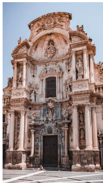
[Fig. 13] Vista del vacío central de la fachada de la Catedral de Murcia.
