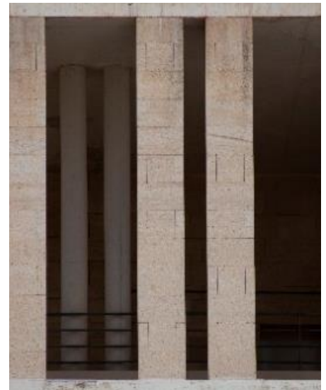
[Fig. 18] Detalle de la fachada, duplicación de pilares. Archivo propio.
