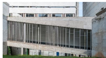
[Fig. 22] Vista exterior de un pasillo de La Tourette, Le Corbusier.
