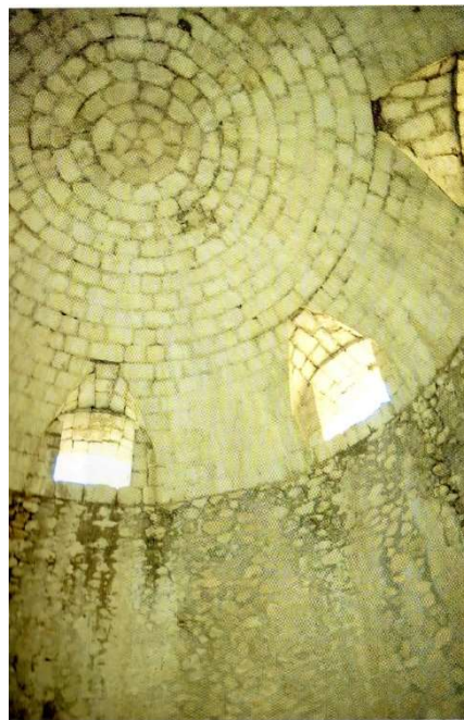
Ilustración 100. Pou del Carrascal, Castalla. Vista interior del pozo. cúpula de sillares de piedra.
