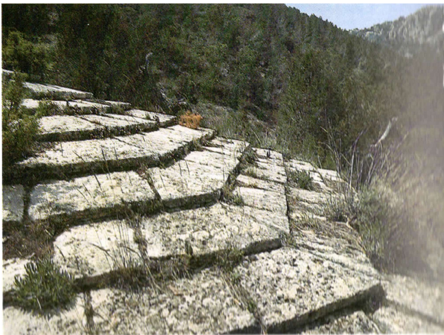
Ilustración 98. Pou del Carrascal, Castalla. Detalle de la forma de cubrición con lajas de piedra.
