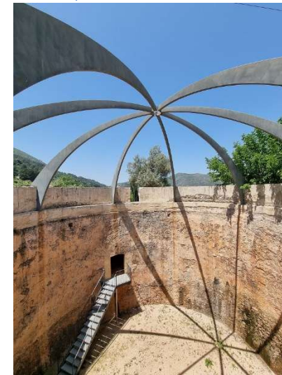
Ilustración 103. Accesos rehabilitados. Valencia Bonita. 2023
