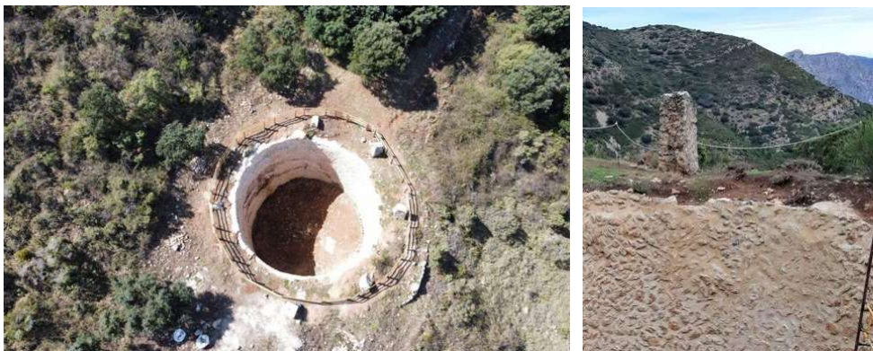
Ilustración 106. Nevero del siglo XVII rehabilitada Diario Las Provincias. 14 mayo de 2021
