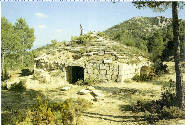
Ilustración 97. Pou del Carrascal, Castalla. Depósito de nieve con una original cubierta de piedra antes de la restauración 2017.
