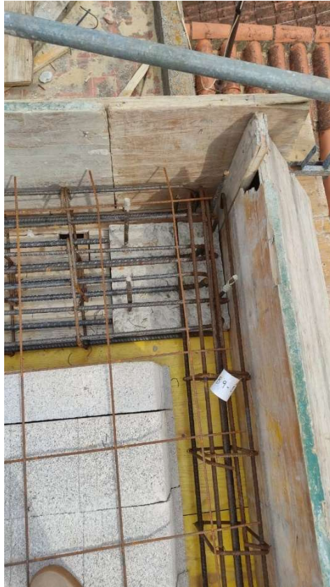
Figura 68. Encuentro de viga con pilar.
