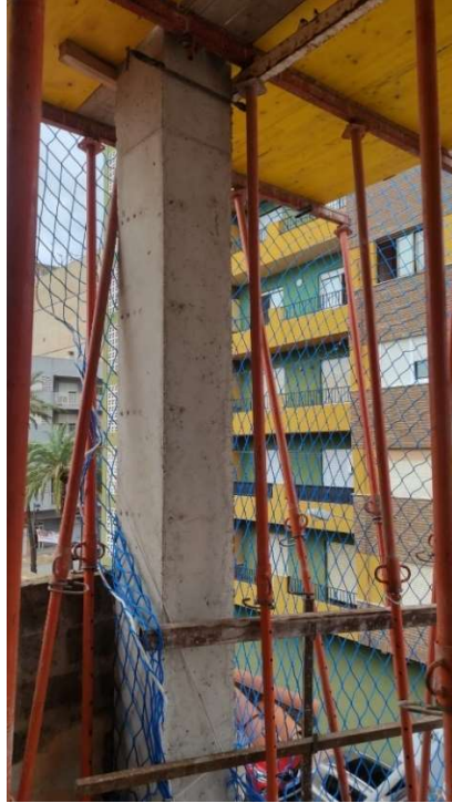
Figura 66. Pilar hormigonado.
