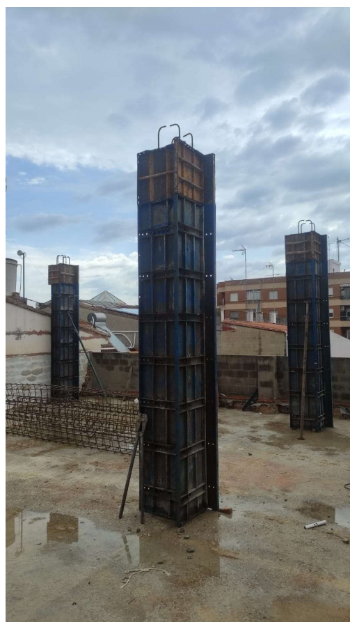
Figura 65. Pilar con la armadura y encofrado.
