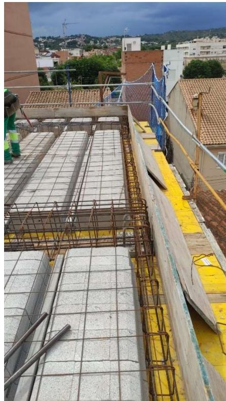
Figura 67. Armadura del forjado.
