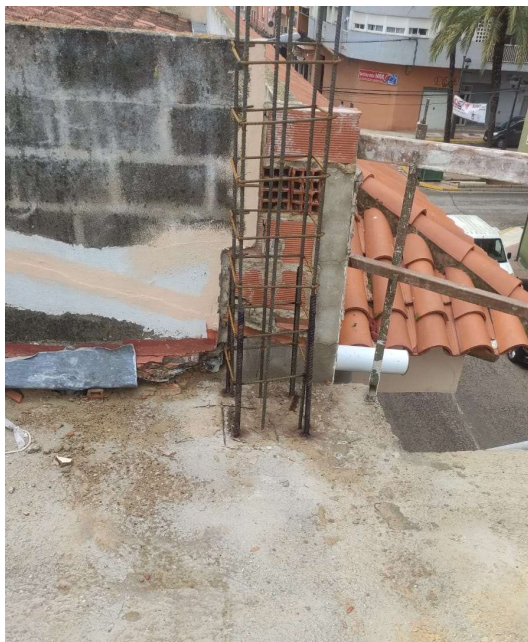
Figura 62. Encuentro entre pilar existente y pilar nuevo.
