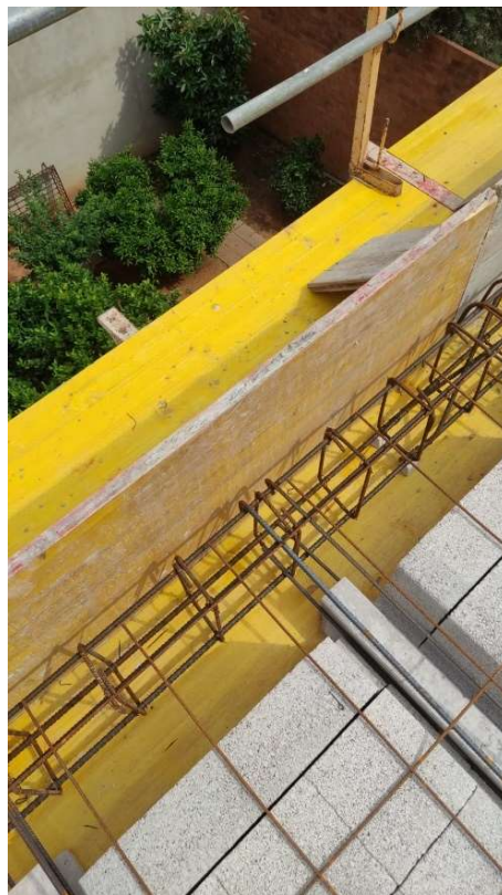
Figura 69. Encuentro de vigueta con viga.
