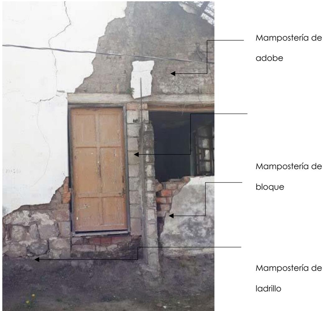
Se puede apreciar la diversidad de elementos constructivos que la edificación posee, en la parte superior existe la mampostería de adobe, mientras que las paredes bajo los vanos de ventanas están elaboradas en ladrillo y las paredes divisorias son realizadas en bloque y lo único que ayuda a tener una unidad son los enlucidos de barro existentes.
