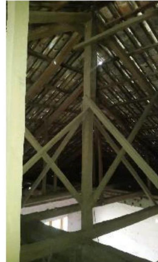
*Ilustración 67 estructura de cubiertas
