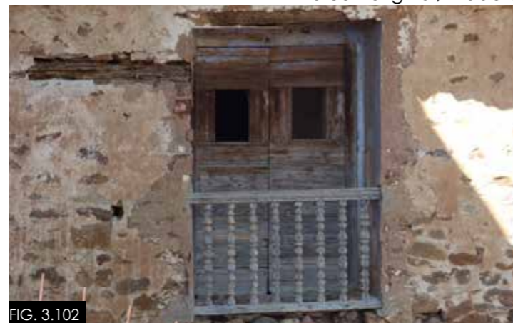
FIG. 3.101 Carpintería, reja madera. Dintel gran formato Balcón original, madera
