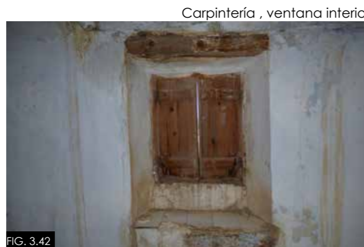
Interior vivienda, revestimiento cal y azulina
