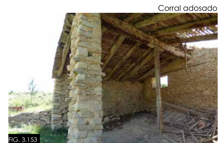
Cubierta de tablones, reformada
