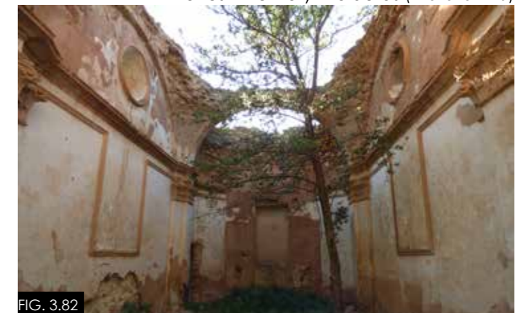
Revestimiento y molduras (interior ermita)
