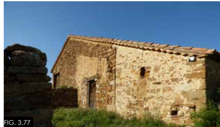
Unión muro visto y revestido
