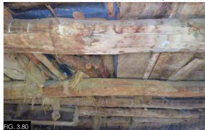
Cubierta de tablas, mal estado
