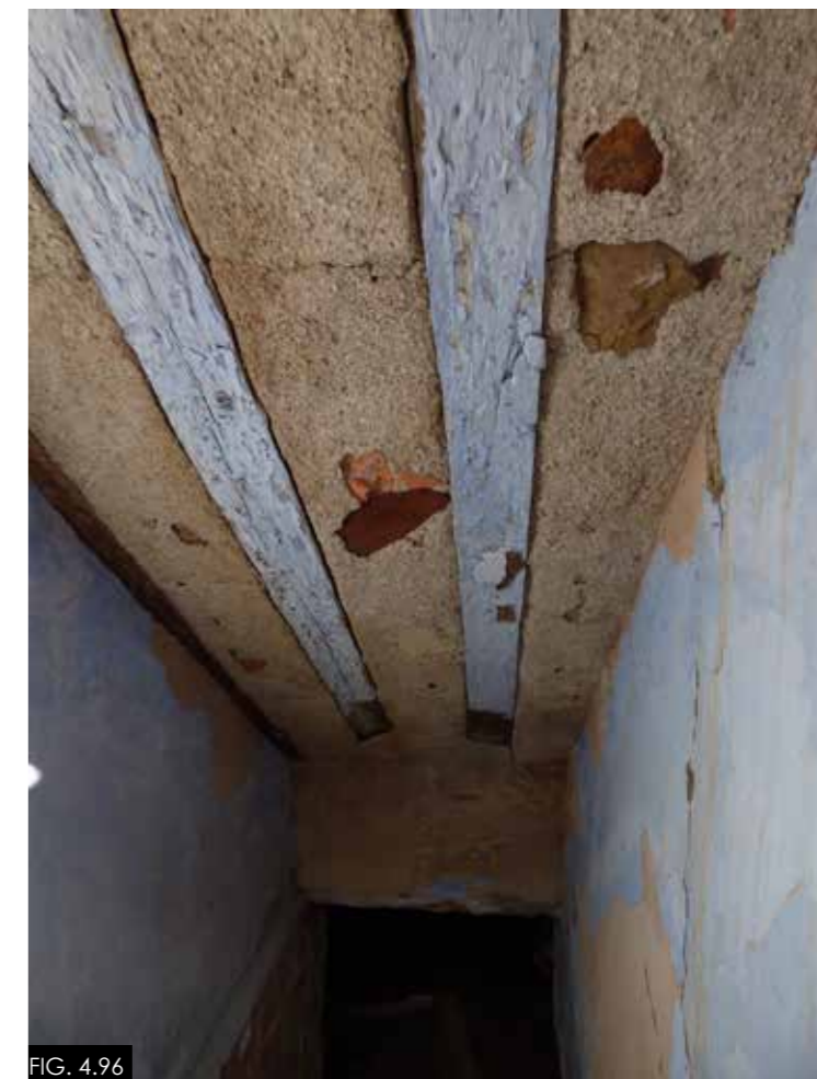
A. Tabique de rasillas B. Relleno de mampostería y yeso C. Rollizos de madera
