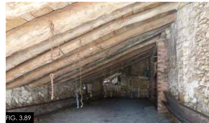
Corral, forjado inclinado de tablas
