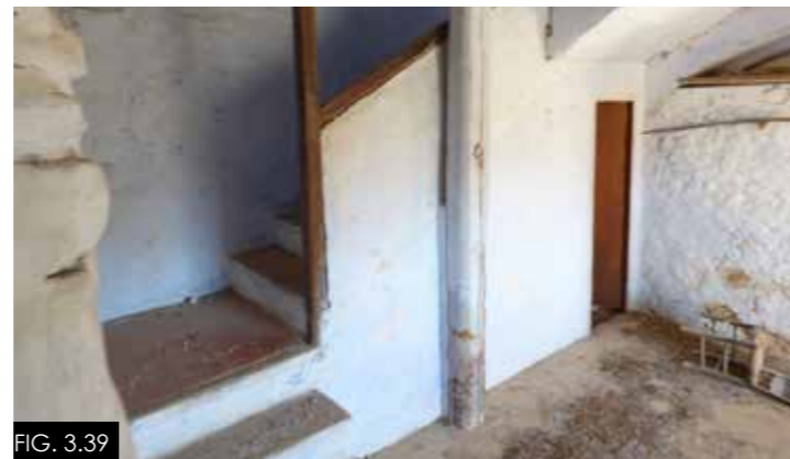
Interior vivienda, revestimiento cal y azulina
