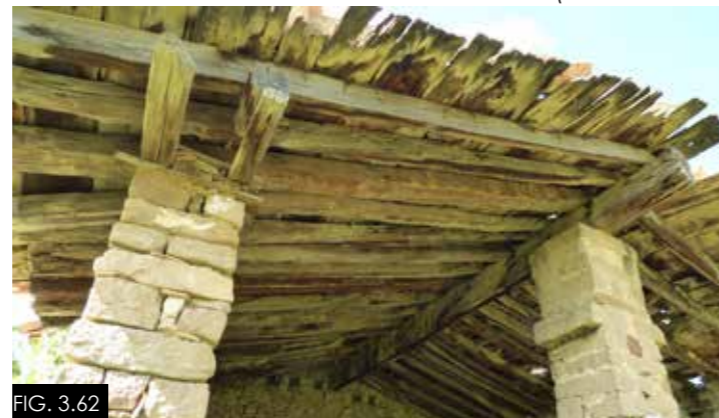
Cubierta de tablas (corral adosado)
