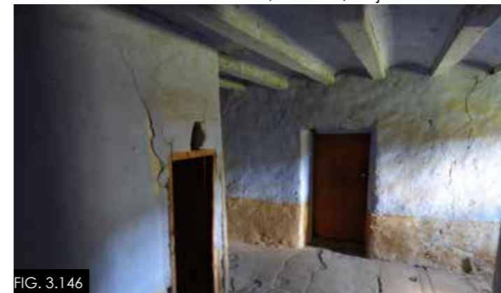
Interior vivienda, azulina, forjado revoltones
