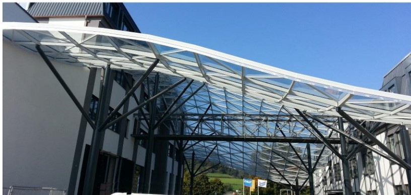
Figura 5-1. Malla espacial monocapa del EGO Roof Erbach.
