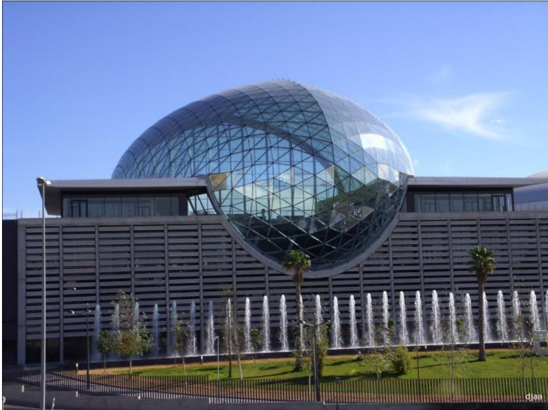
Figura 3-8. Fachada Sureste del Centro de Eventos.
