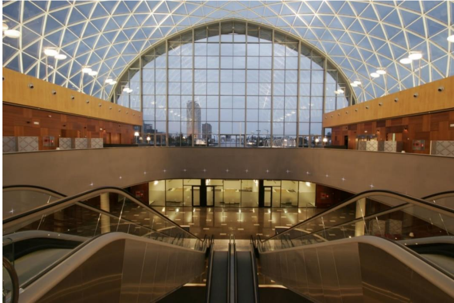
Figura 4-5. Vista interior de la cubierta del Centro de Eventos y su núcleo de comunicación.
