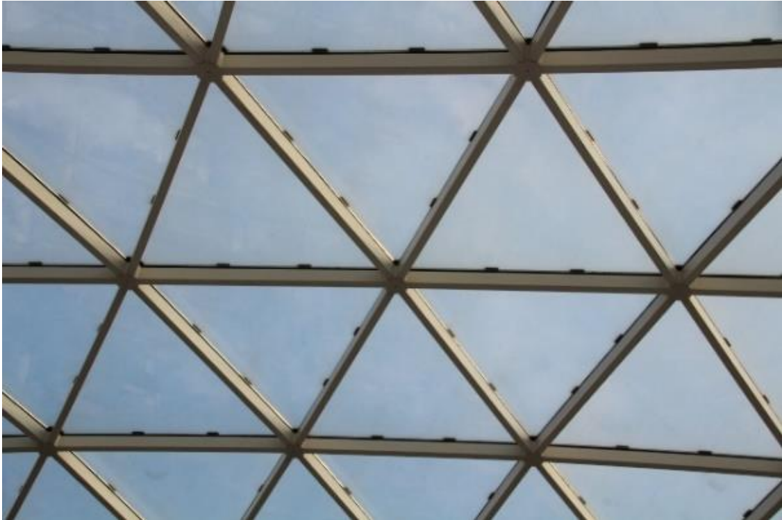
Figura 5-4. Malla espacial monocapa de la cubierta del Centro de Eventos.
