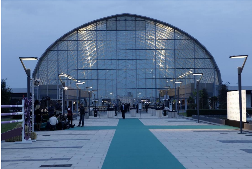
Figura 4-4. Fachada de acceso del Centro de Eventos.
