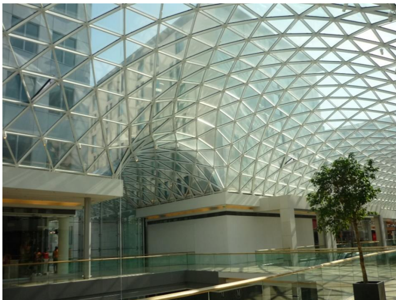
Figura 5-2. Malla espacial monocapa del International Trade Centre EUROVEA.
