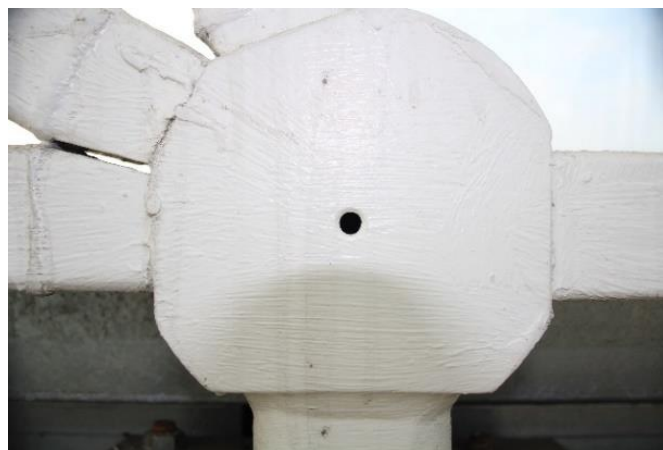
Figura 5-5. Nudo de unión de las barras de la estructura. Fotografía in situ.
