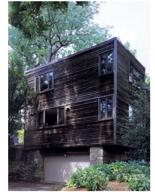
Figura 57. Louis Kahn. Fachada de acceso al garaje.
