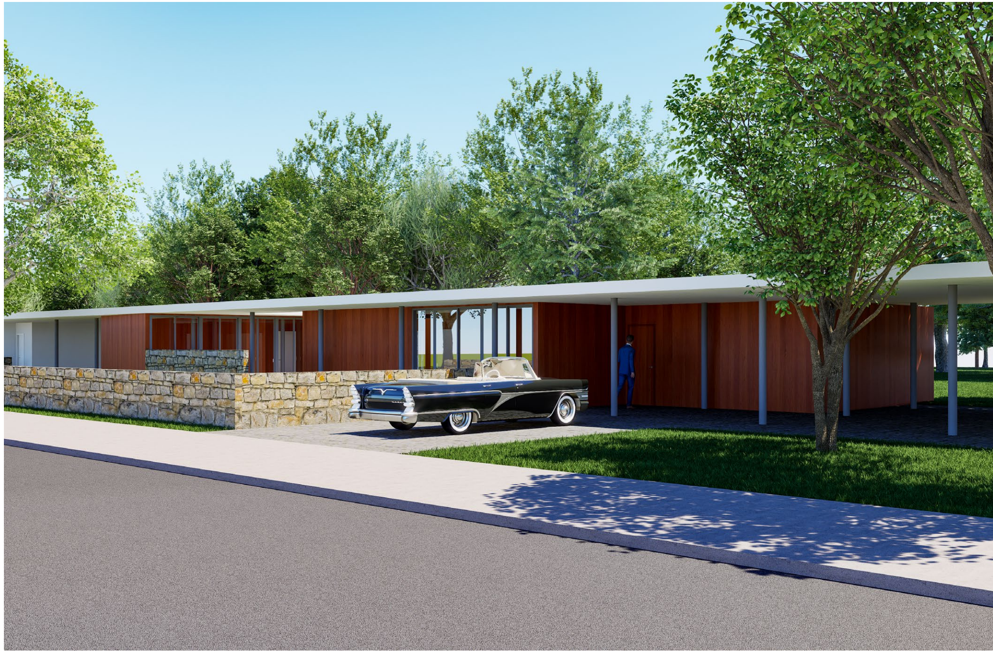
Figura 106. Elaboración propia. Vista a pie de calle de la vivienda tipo A "estilo Casa Genel". Pilares metálicos con acabados grises.
