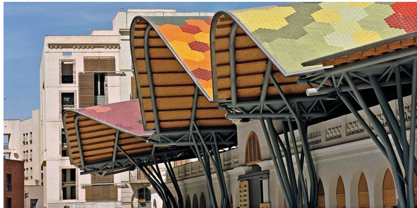
Figura 129. Fotografía exterior - materialidad de la cubierta.
