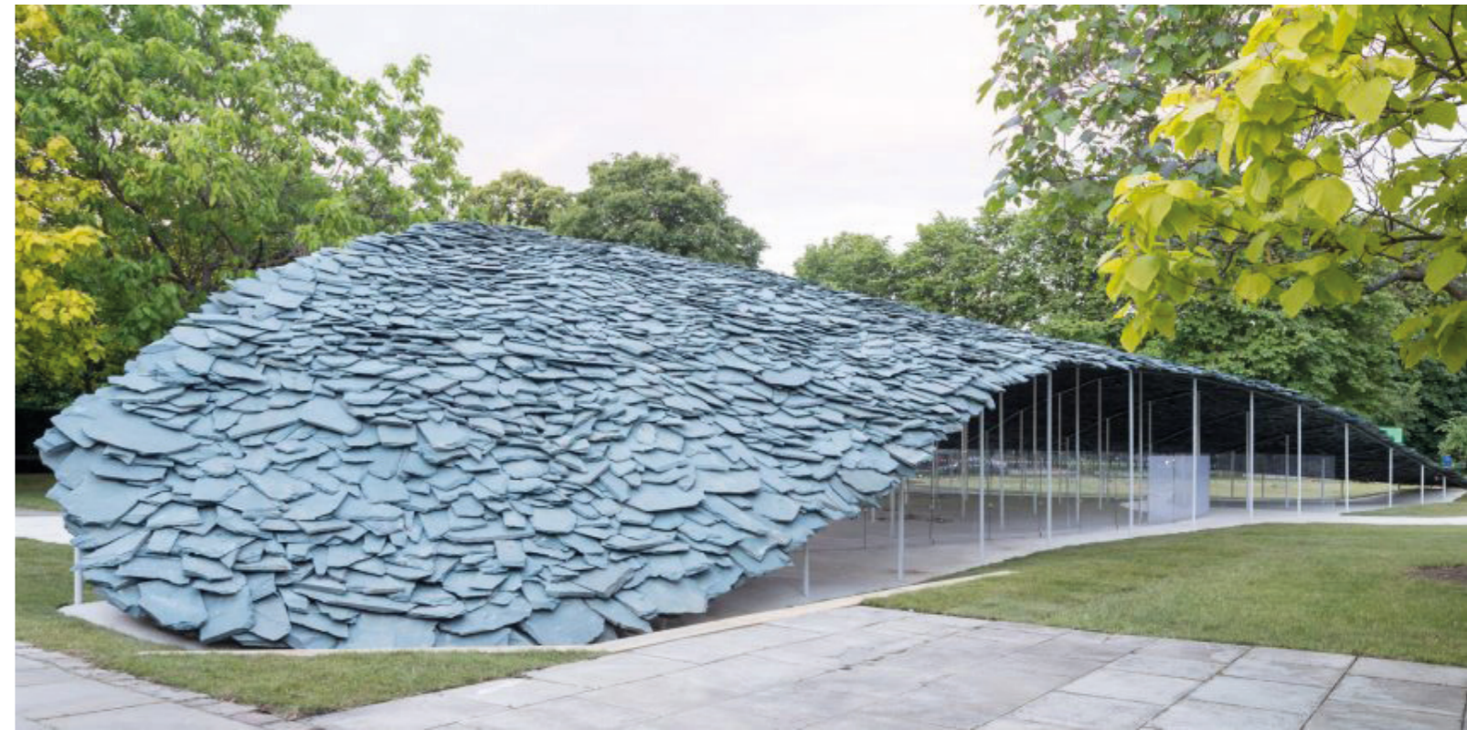
Figura 185. Vista exterior de la cubierta.
