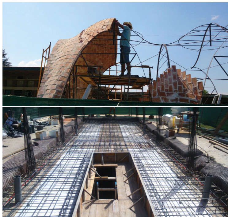
Figura 159. Guías metálicas para realizar las curvas.
