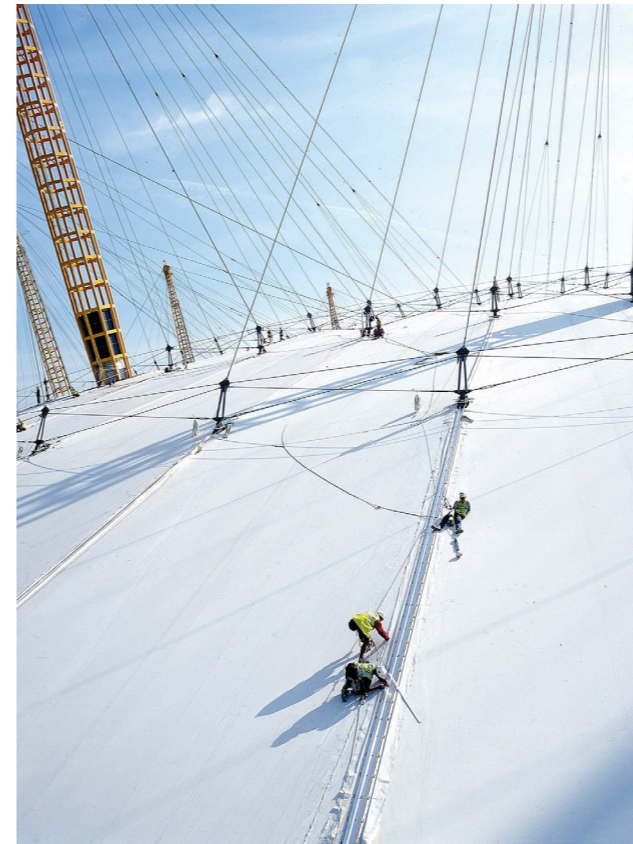
Figura 120: Materialidad y escala de la cubierta. Figura 121: Espacio interior.
