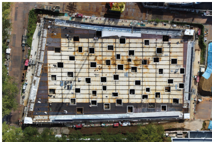
Figura 195. Imagen durante la construcción.
