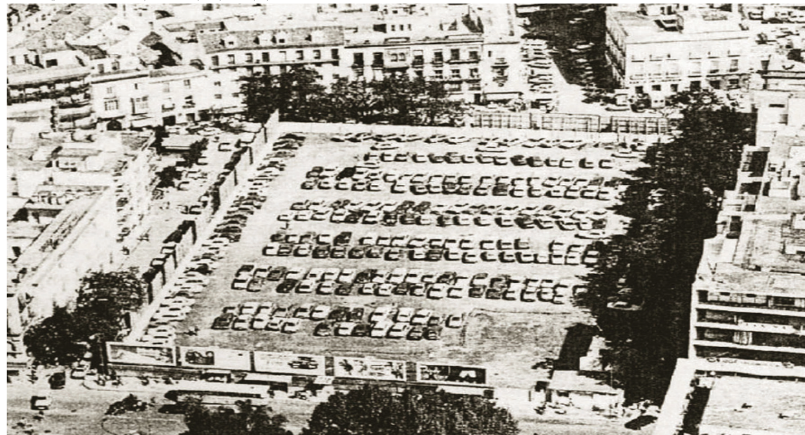
Figura 149. Funcionalidad y estado de la plaza previa al proyecto.
