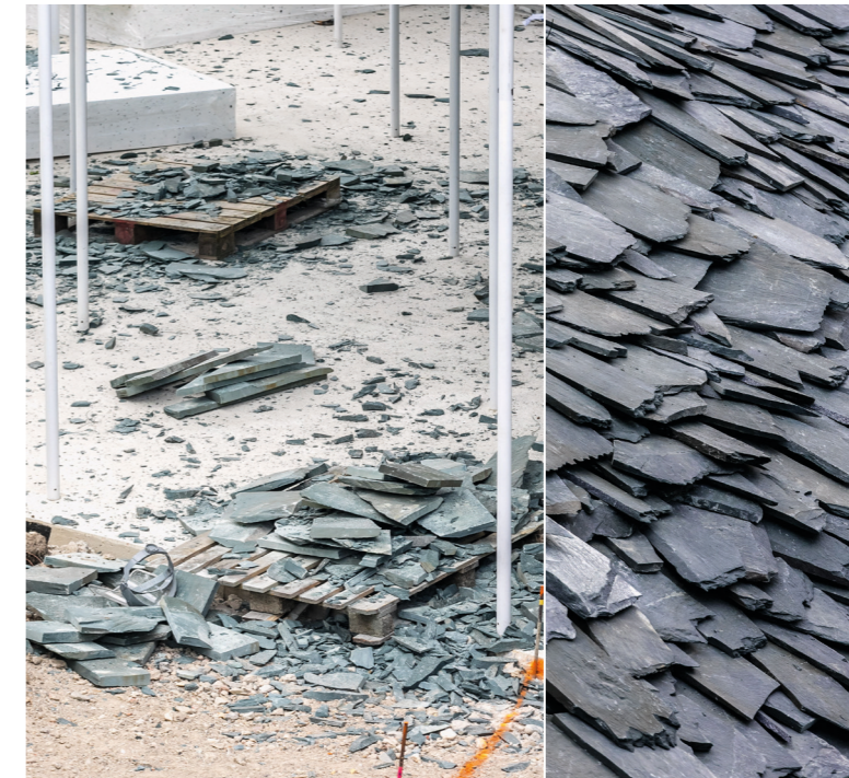
Figura 188. Restos de materiales de cubierta Figura 189. Materialidad de la cubierta, pizarra.
