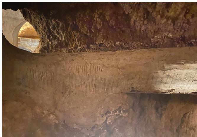
Figura 21: Marcas rasgadas en bodega. [e.p]
