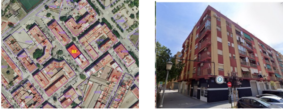
Imagen 3.95 Emplazamiento y alzado del edificio sito en C/Cora Raga. Google maps
