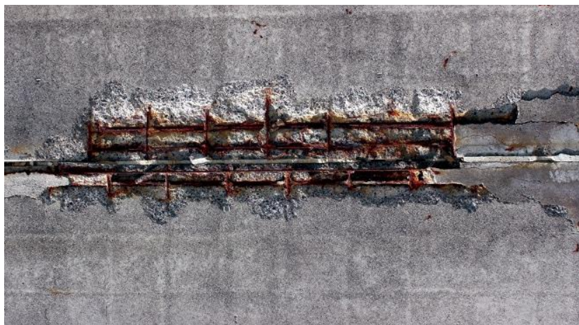
Figura 12. Corrosión galvánica (2020) [22]
