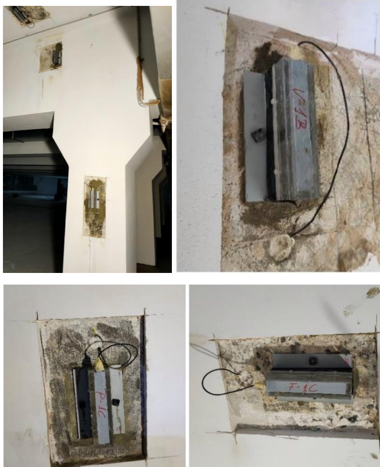
Figura 39. Sensor instalado en elemento
