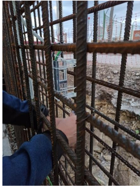
Figura 75. Instalación de sensor de corrosión en muro
