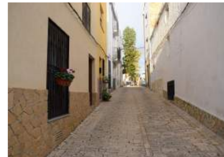
Despiece del pavimento: Calle Villavieja.
