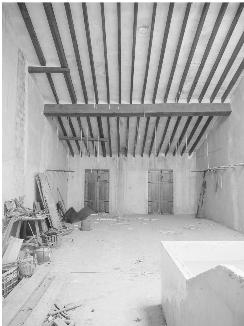
la planta superior, espacio diáfano
