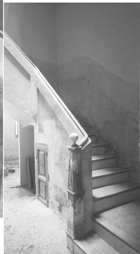
primer tramo de escalera
