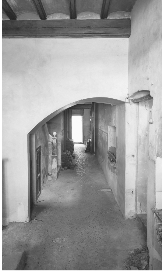
vista de planta baja, hacia la puerta de la calle
