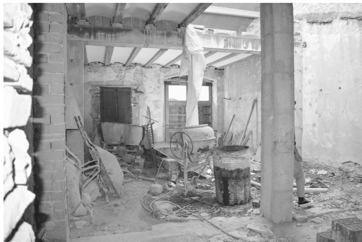
corral en la planta baja, acopio
