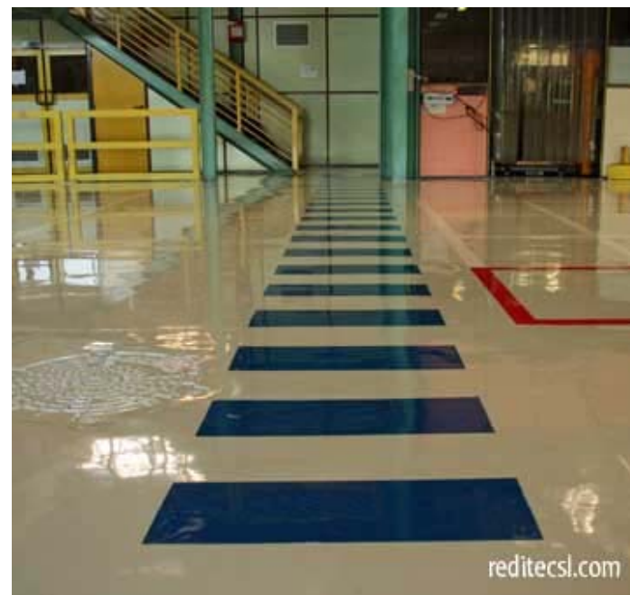
Paviment de resina d' aplicació in situ , es projecta a les zones de pas de vehicles com al soterrani destinat a aparcament.
