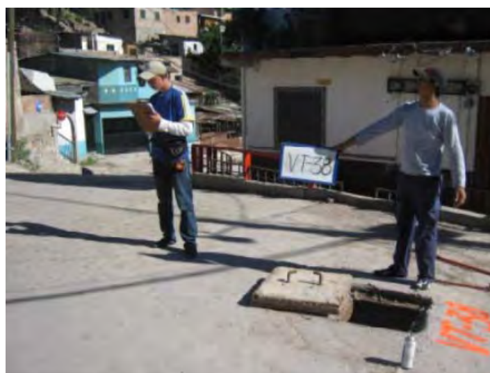
Figura N°5 Levantamiento de una válvula.
