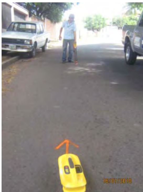
Figura N°8 Operario utilizando equipo para detección de tuberías metálicas.
