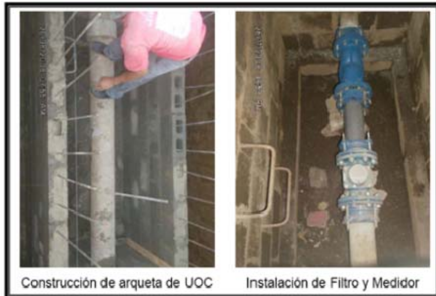
Figura N°45 Modelo de UOC a la entrada de los sectores sin by pass.
