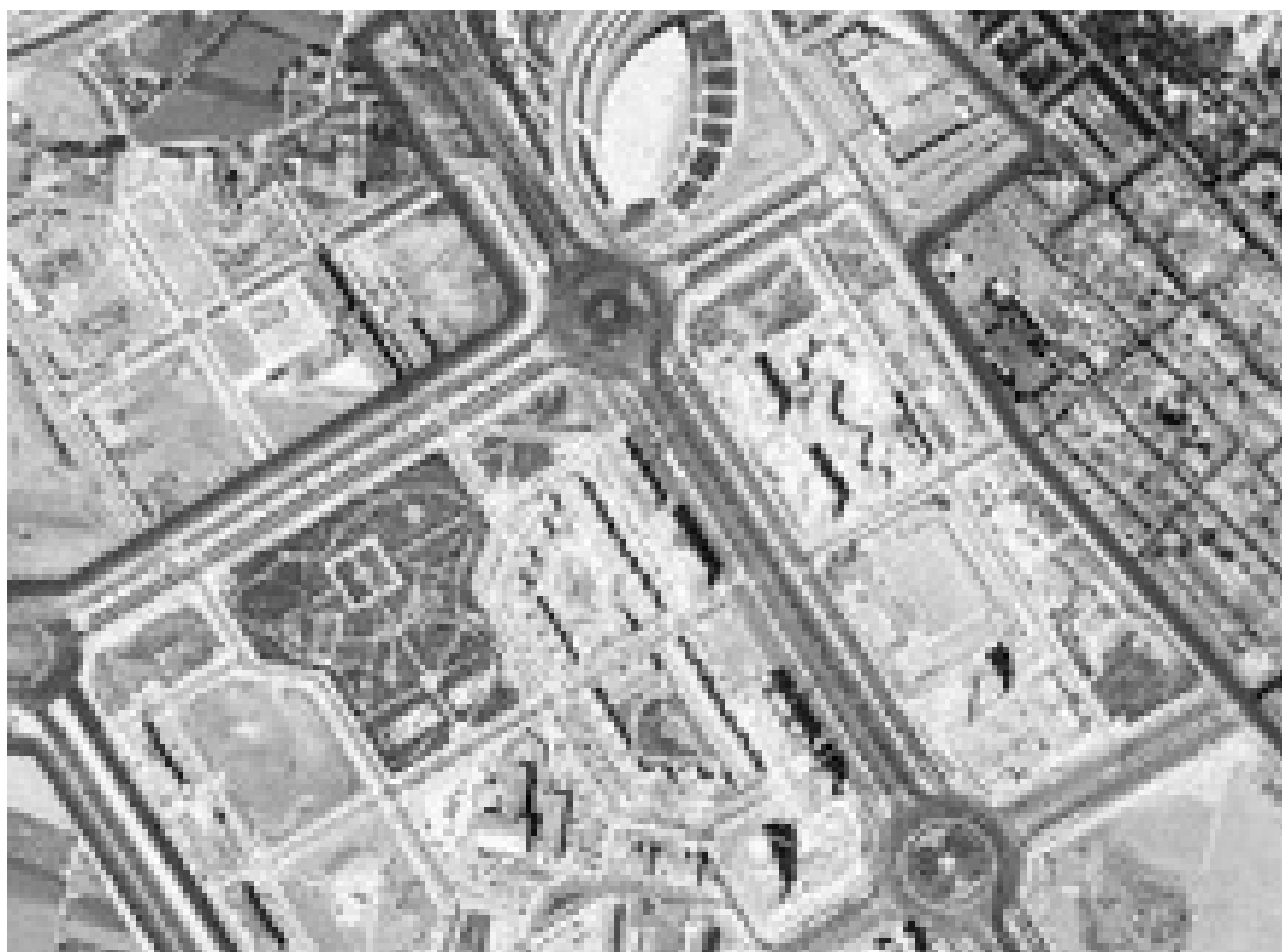
fig. 236: EL BARRIO DE ADEMUZ. FOTOGRAFÍA AEREA (EN CONSTRUCCIÓN).
