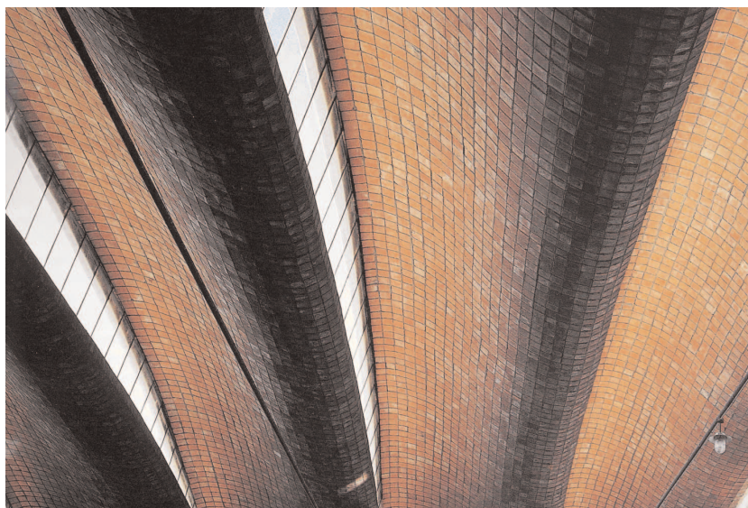
Fig. 33. Depósito Julio Herrera. Vista longitudinal interior. Fuente: op. cit. pág. 80.
