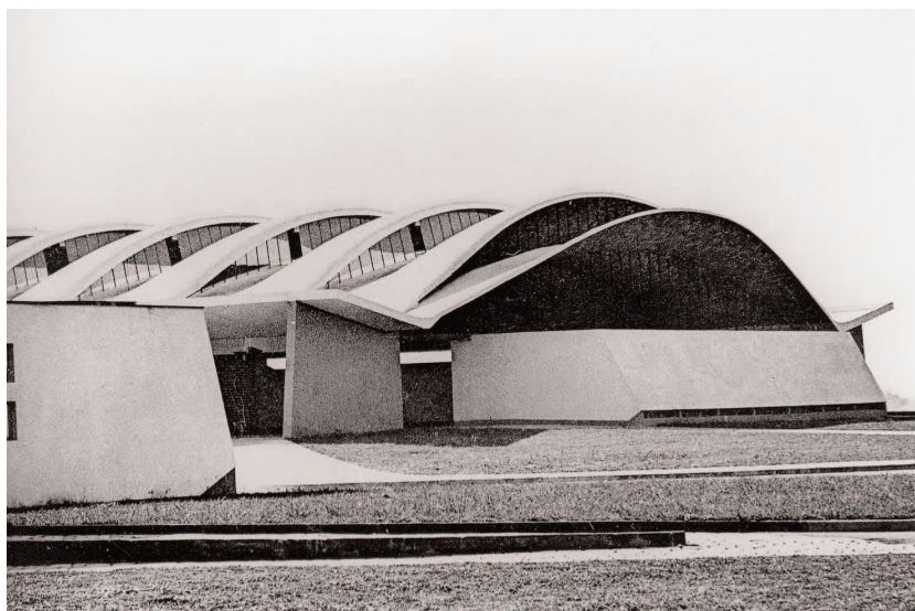
Fig. 30. Vista exterior de la cubierta del depósito Julio Herrera. Fuente: op. cit. pág. 76. Fig. 31. Mercado de Porto Alegre. Fuente: op. cit. pág. 63. Fig. 32. Depósito Julio Herrera. Vista interior. Fuente: op. cit. pág. 77.
