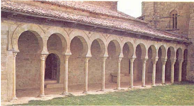
Figura 94 (arriba): Pórtico de la iglesia de San Miguel de la Escalada. León.
