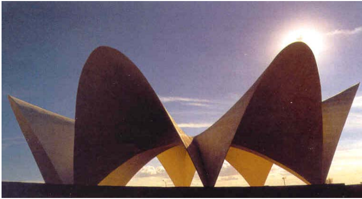
Figura 289 (arriba): Santiago Calatrava. Cubierta con paraboloides hiperbólicos del restaurante del Oceanográfico. Ciudad de las Artes y las Ciencias de Valencia.
