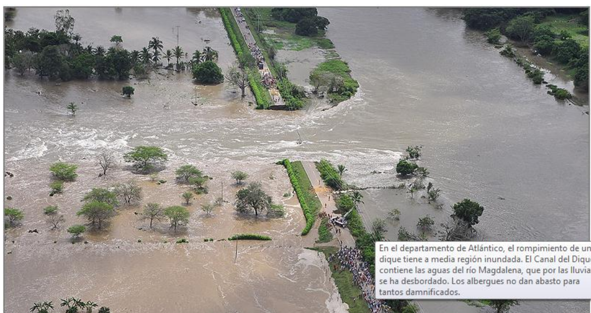
Figura 6-15. Rotura del Canal del Dique debida a temporada de lluvias, 30/11/2010 (elheraldo.com.co)
